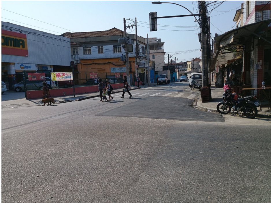
Foto 5: Término da obra na esquina da Rua Verna Magalhães com a Rua Cabuçu.
