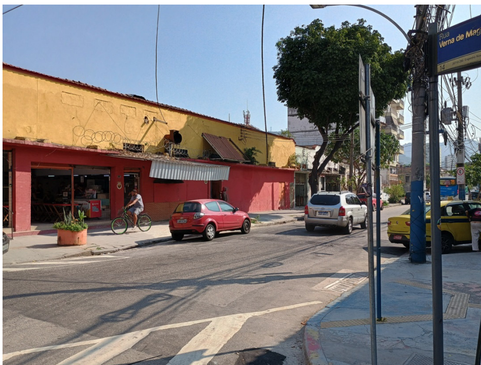
Foto 4: início da obra na esquina da Rua Verna Magalhães com a Rua Barão do Bom Retiro.
