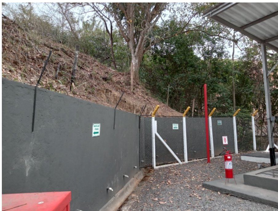
Foto 8: Sinalização de rota de fuga.
