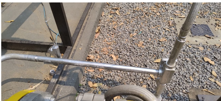
Foto 16: Adequação de duto elétrico.
