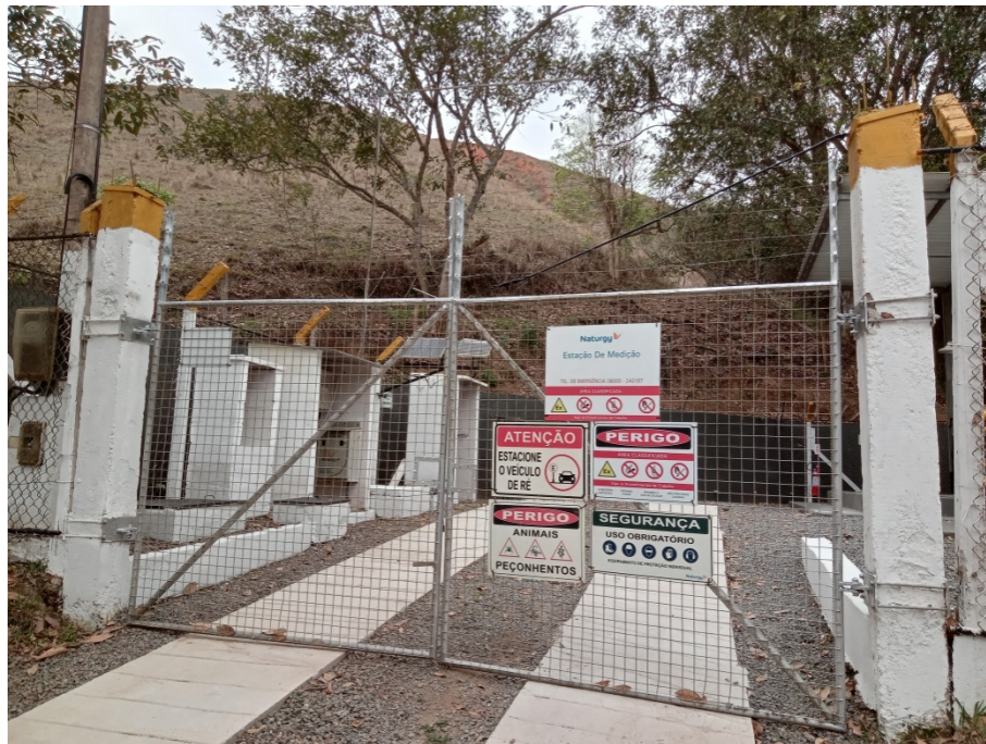
Foto 2: Entrada da estação e sinalização de segurança.
