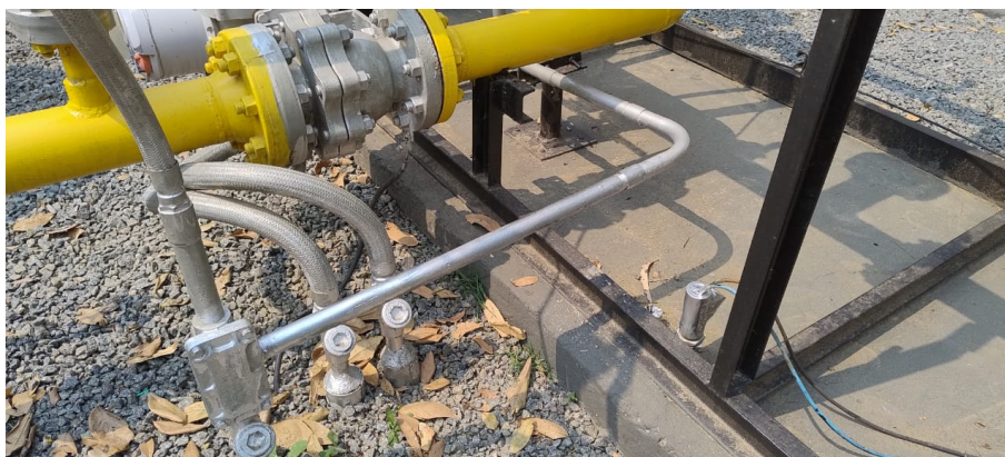
Foto 15: Adequação de duto elétrico.
