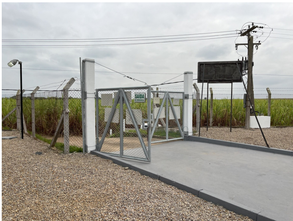
Foto 13: Sinalização de saída de emergência.
