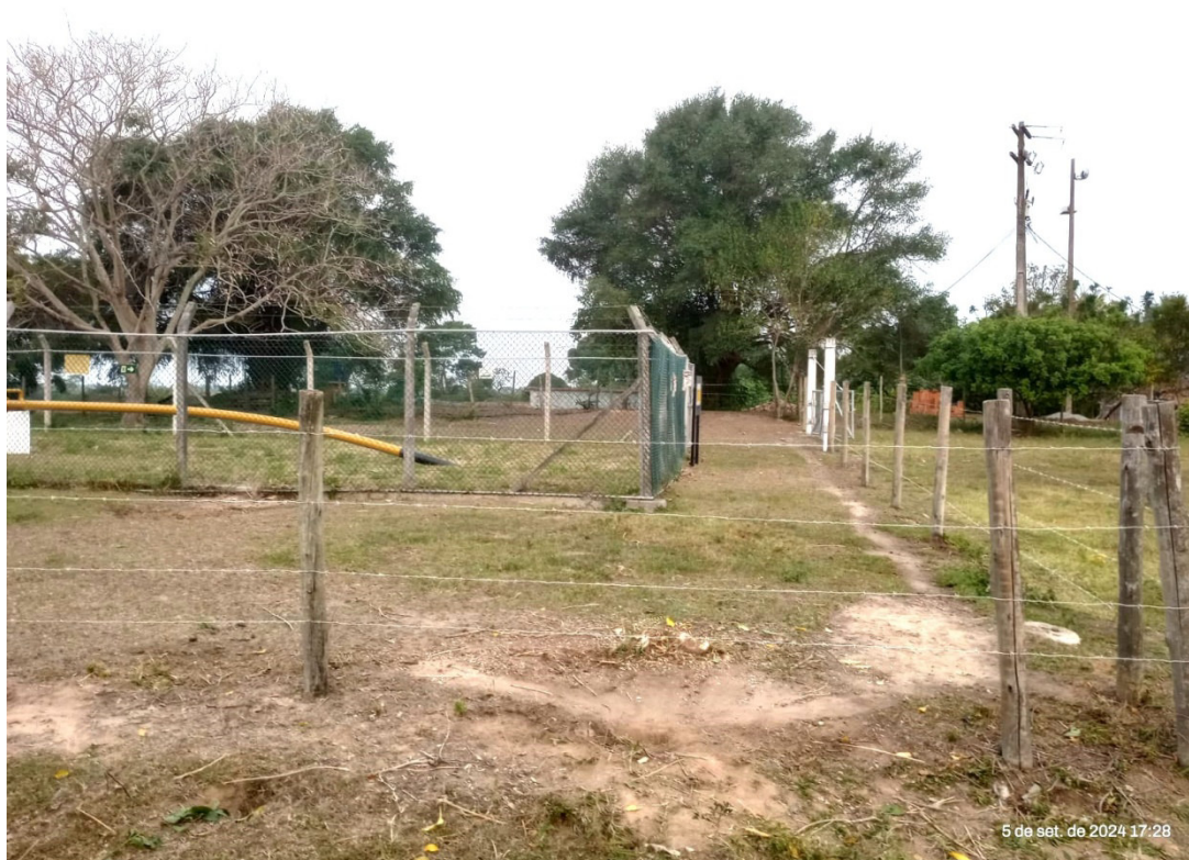
Foto 9: Cerca externa reparada.
