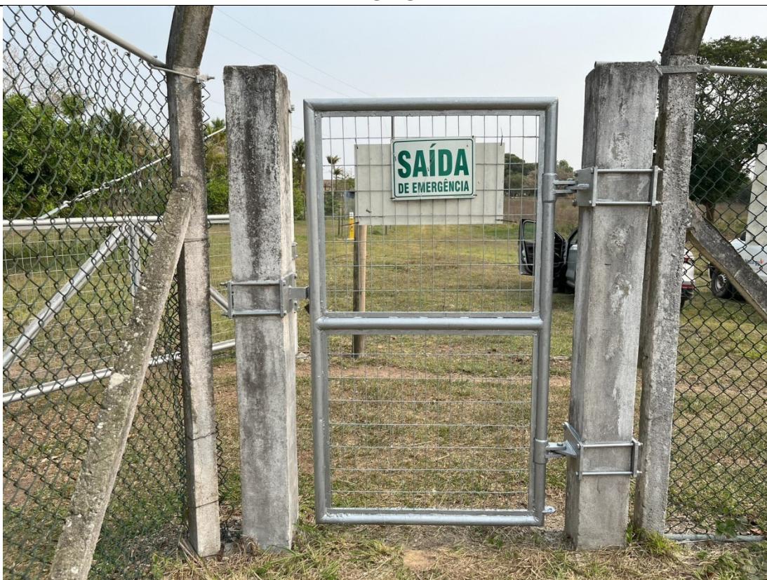
Foto 8: Placa de saída de emergência no portão.
