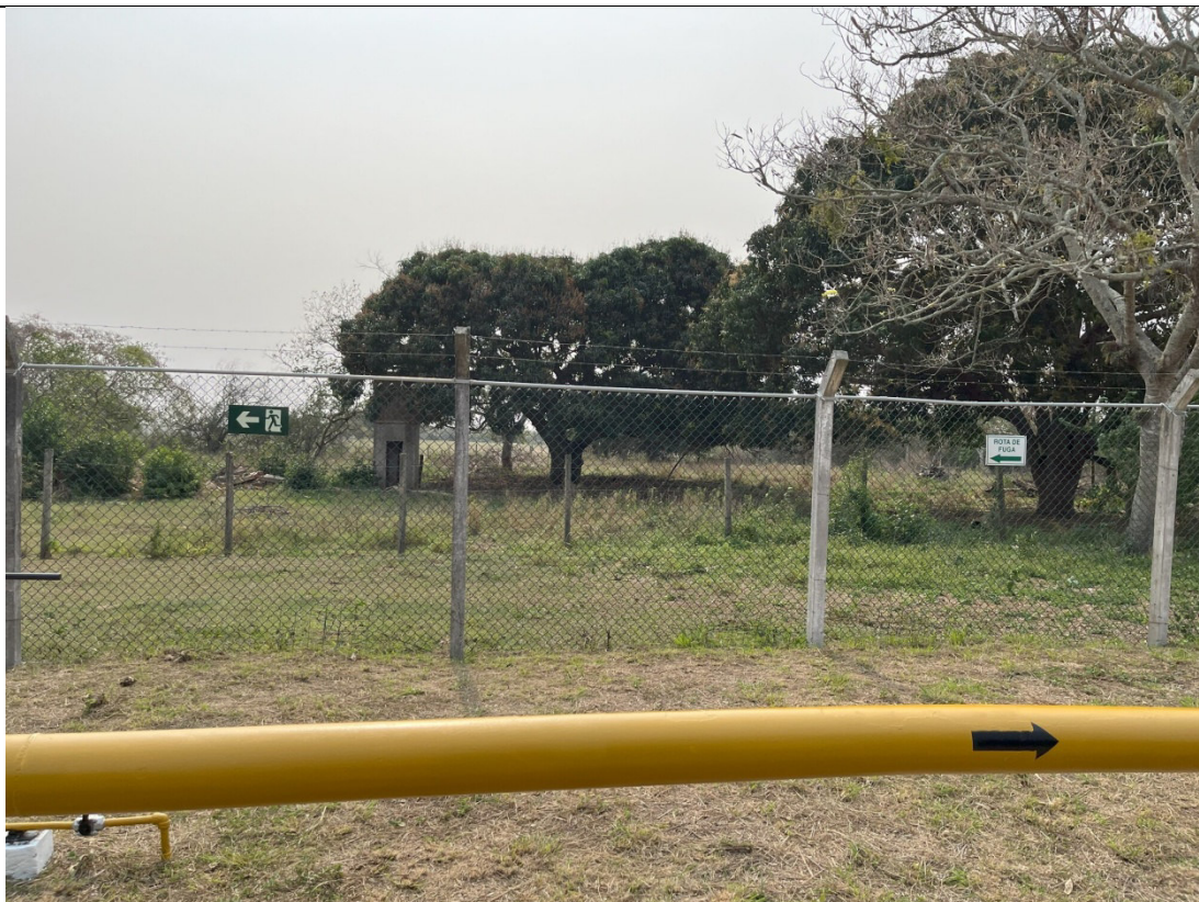
Foto 7: Gasoduto à frente; placas de saída e rota de fuga ao fundo.
