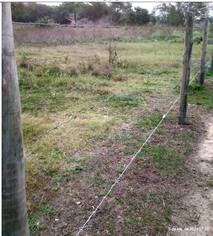
Foto 12: Cerca externa reparada.
