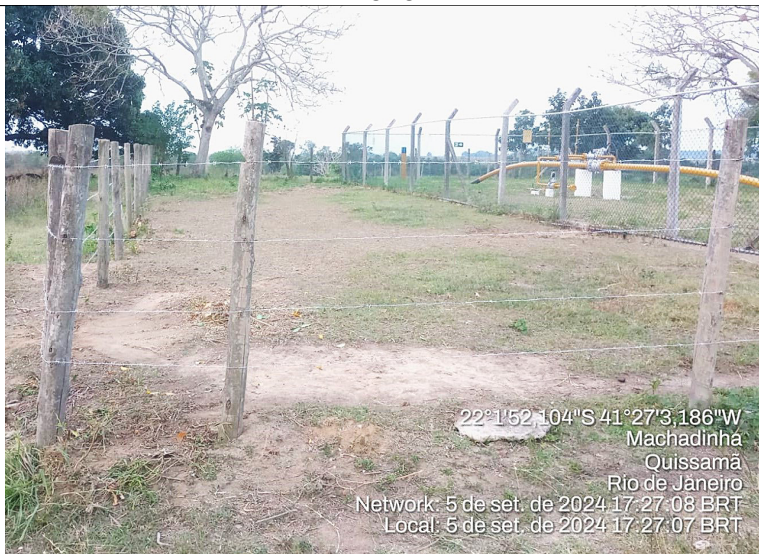
Foto 10: Cerca externa reparada.
