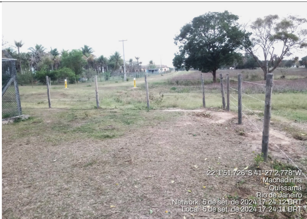
Foto 11: Cerca externa reparada.
