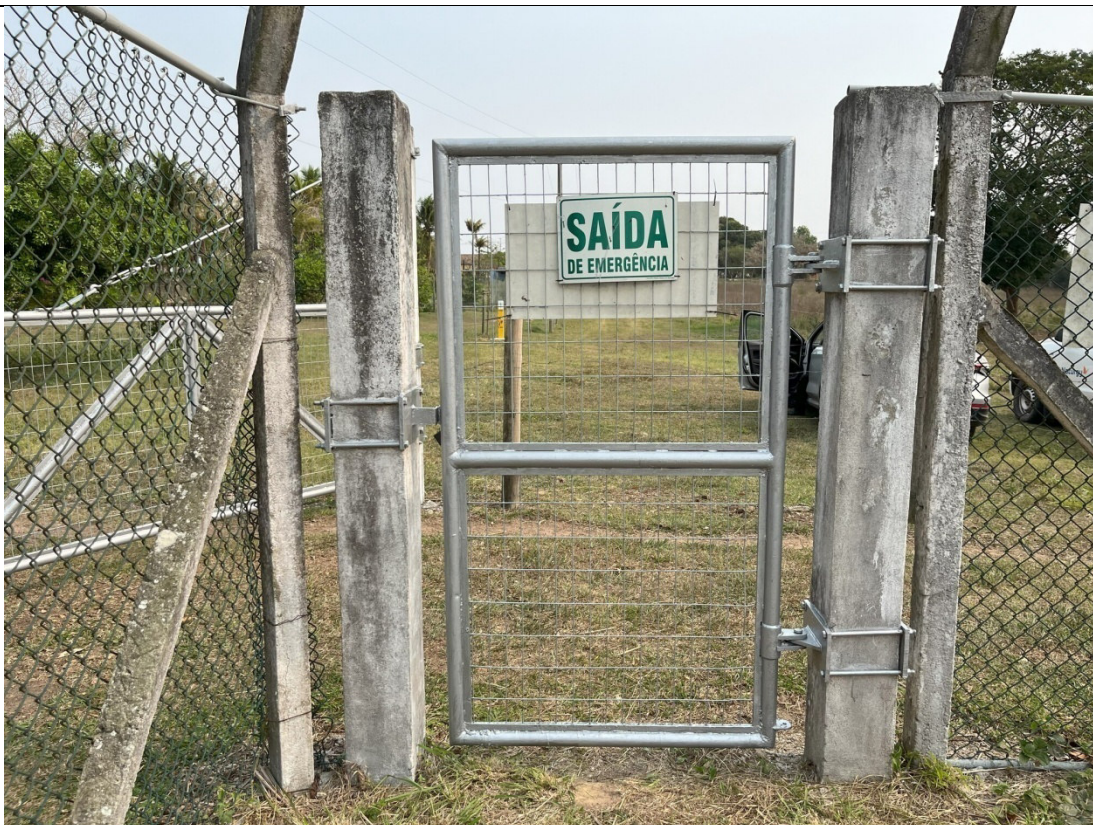
Foto 8: Placa de saída de emergência no portão.
