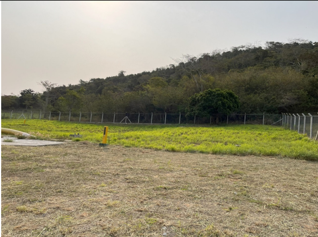
Foto 9: Capina do terreno na área de válvula.
