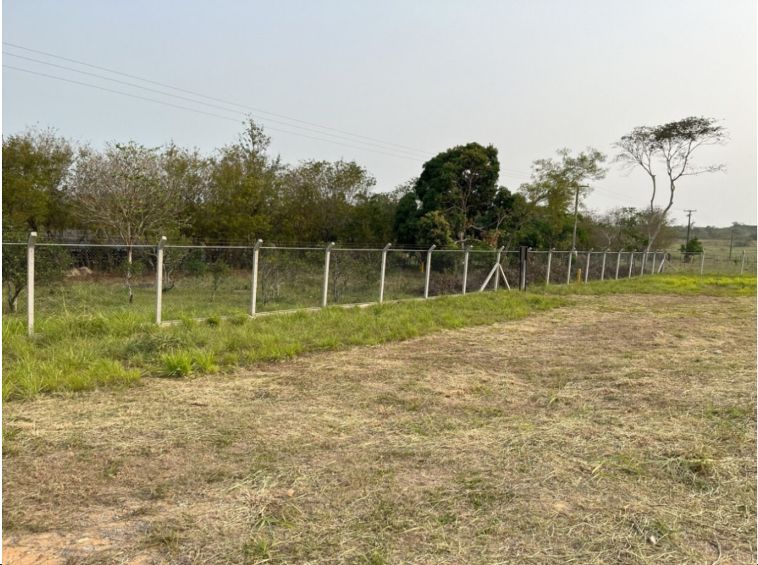
Foto 8: Capina do terreno na área de válvula.
