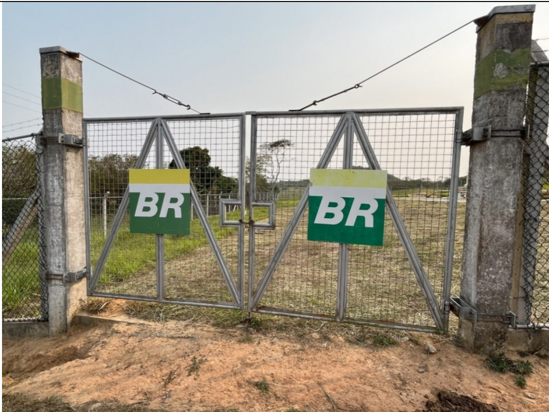
Foto 1: Portão de acesso à área de válvula da Transpetro.
