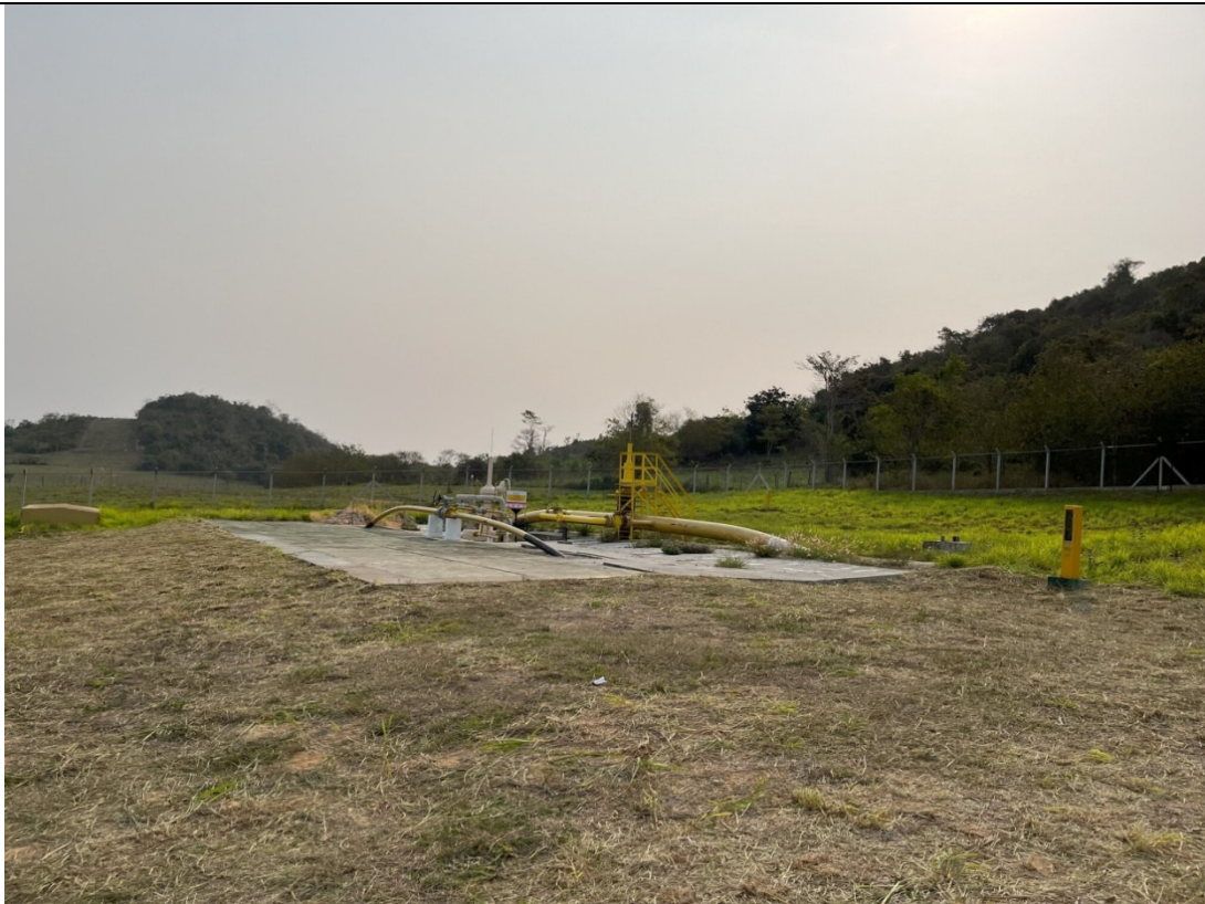
Foto 3: Vista da área de válvula.
