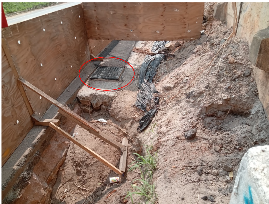
Foto 2: Ponto onde será realizada a interligação em uma extremidade da rede - (Caixa de válvula de rede em destaque).
