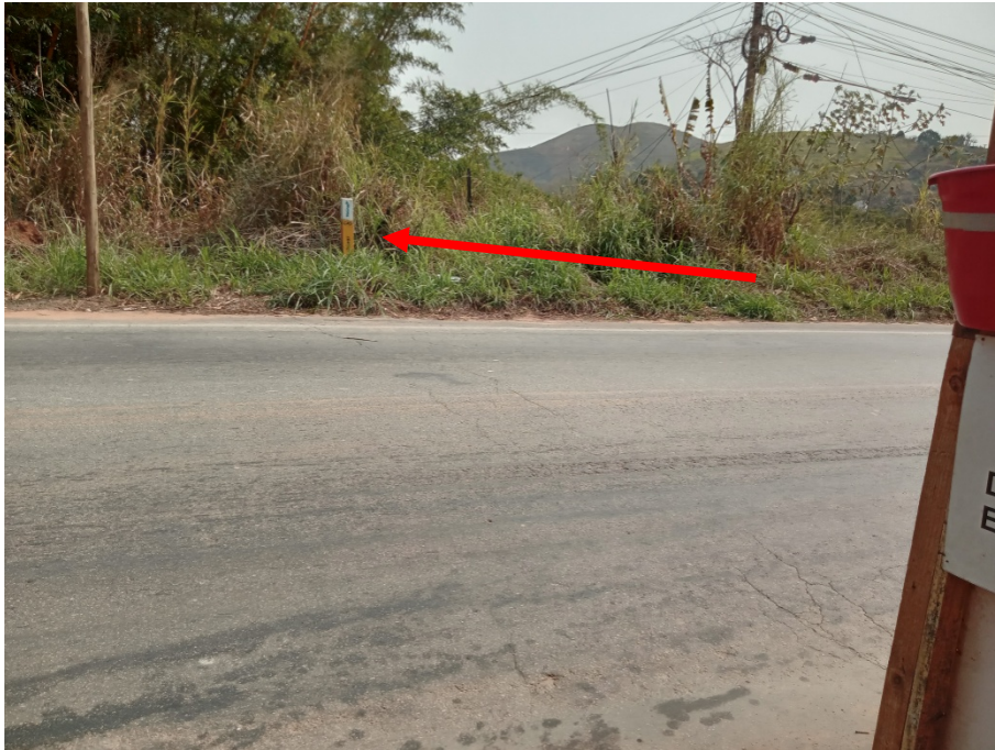
Foto 3: Marco vertical de concreto da rede de gás existente PE Ø250 mm.
