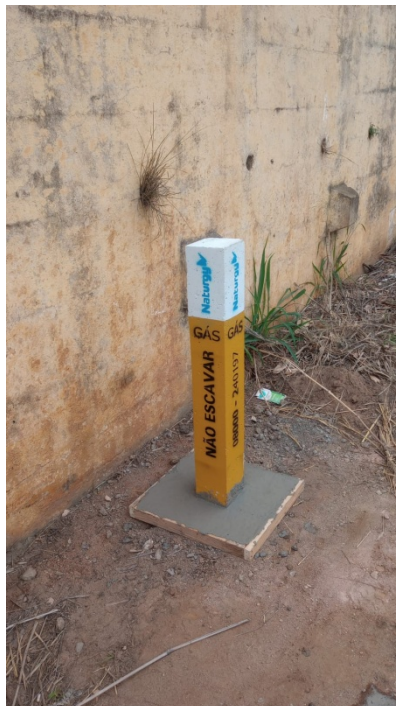
Foto 12: Adequação de marco vertical de concreto.
