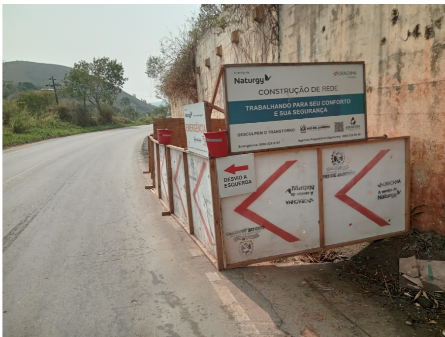
Foto 1: Ponto de início da obra de assentamento de rede de gás natural PE Ø250 mm (lado ímpar).
