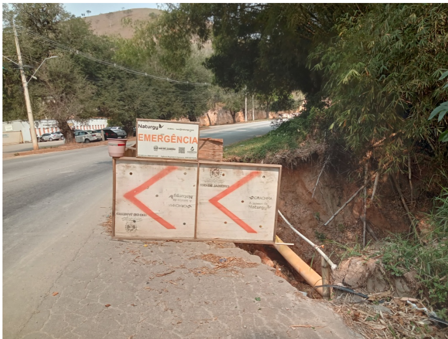
Foto 9: Isolamento e sinalização.
