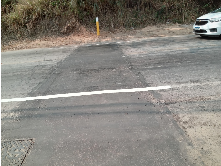
Foto 7: Recomposição em trecho onde foi realizada travessia de rede.
