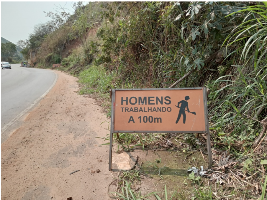
Foto 4: Aviso de obra.
