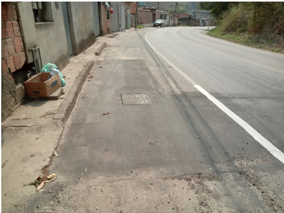
Foto 8: Recomposição em local de instalação de caixa de válvula de rede, onde será realizada a interligação.
