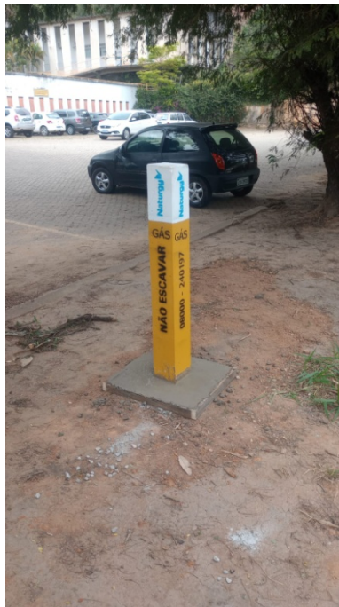
Foto 13: Adequação de marco vertical indicando a presença de rede de gás enterrada.
