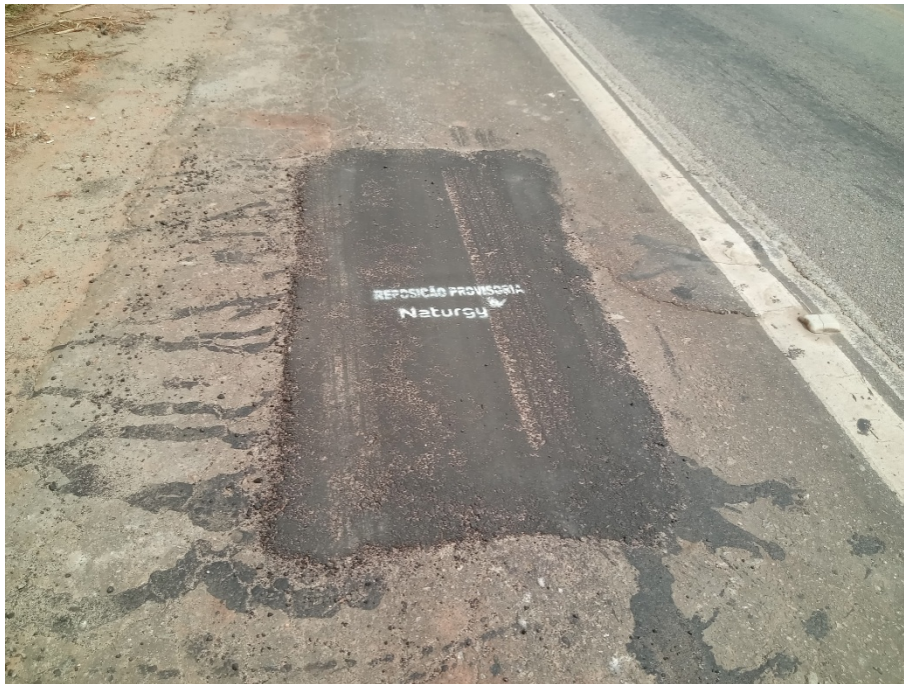
Foto 5: Recomposição provisória da via em ponto de abertura.
