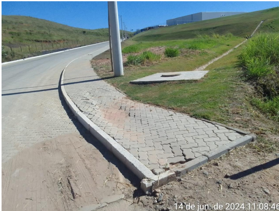
Foto 9: Foto tirada antes da construção da rede de gás.
