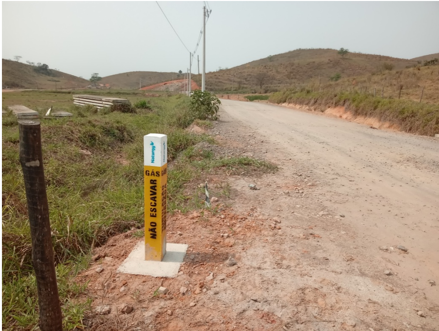
Foto 5: Marco vertical no início da estrada de terra.
