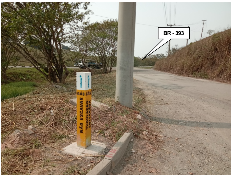
Foto 8: Ponto de interligação entre a rede construída PE Ø110 mm e rede PE Ø200 mm a ser construída (fase 3).
