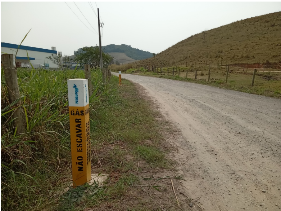
Foto 6: Marco vertical de concreto ao longo da estrada sem pavimentação.
