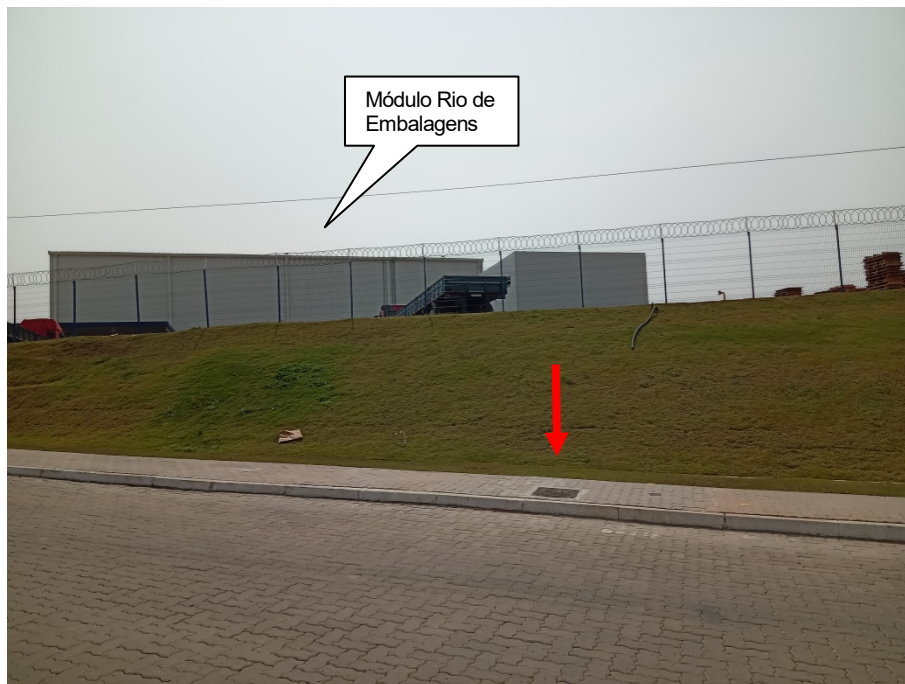
Foto 1: Ponto de início da obra de assentamento de rede de gás natural (em frente à empresa Módulo Indústria de Embalagens).
