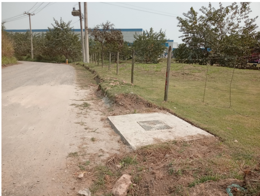
Foto 7: Caixa de válvula de rede próxima ao final do trecho de rede assentada.
