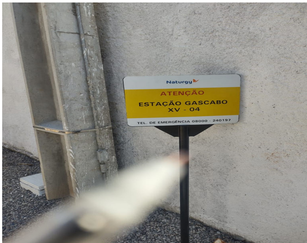
Foto 2: Estação de regulação e medição.
