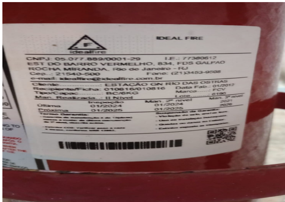
Foto 9: Validade da inspeção dos novos extintores.
