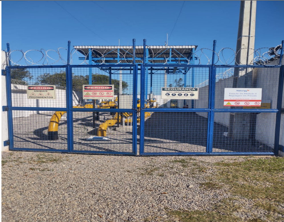
Foto 1: Portão principal com placas de sinalização de segurança.
