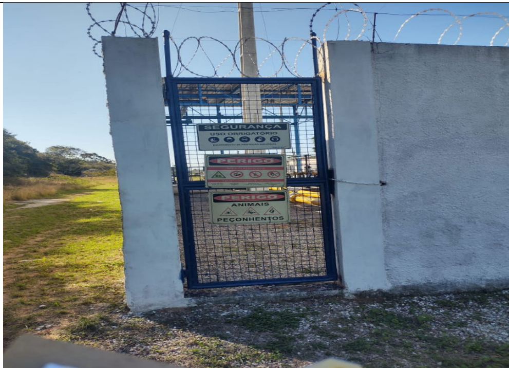
Foto 5: Portão dos fundos com placas de sinalização de segurança.
