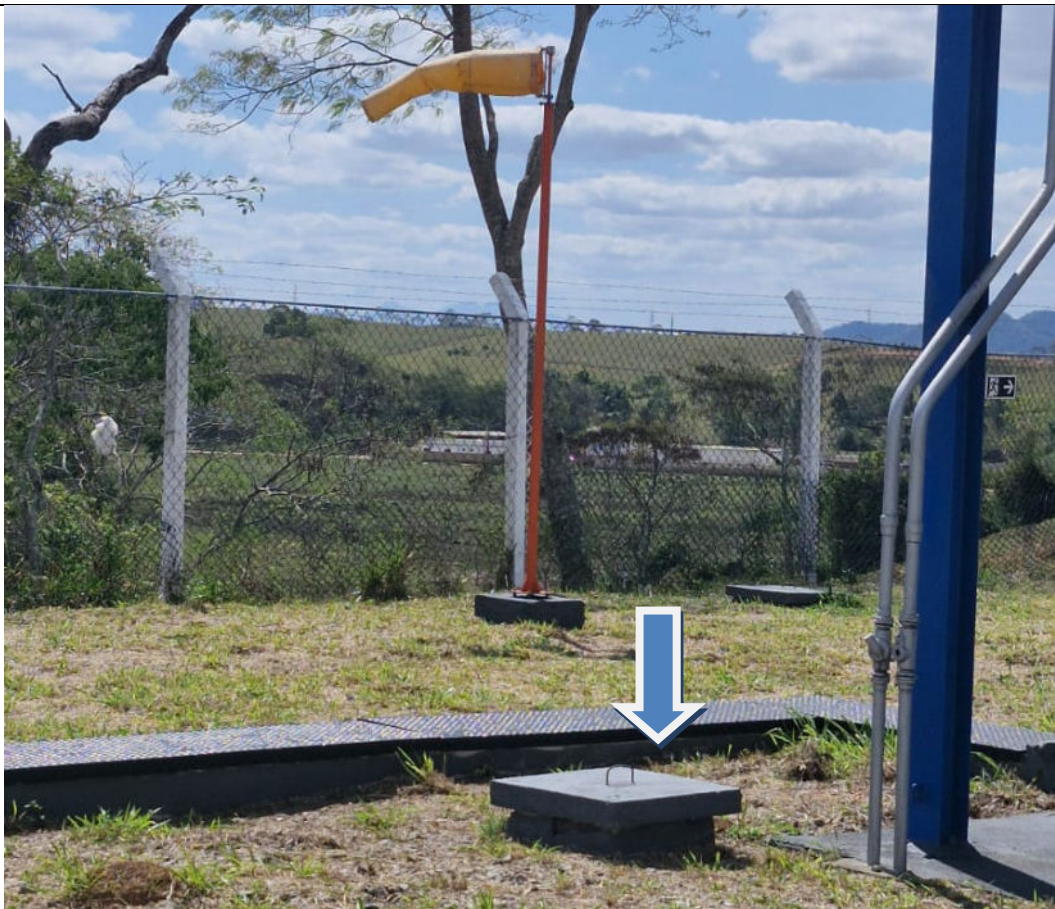
Foto 7: Anemômetro ao fundo da estação, tomada de potencial no destaque.
