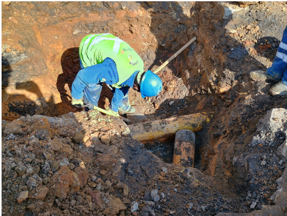
Foto 5: trecho de interligação em uma das extremidades.
