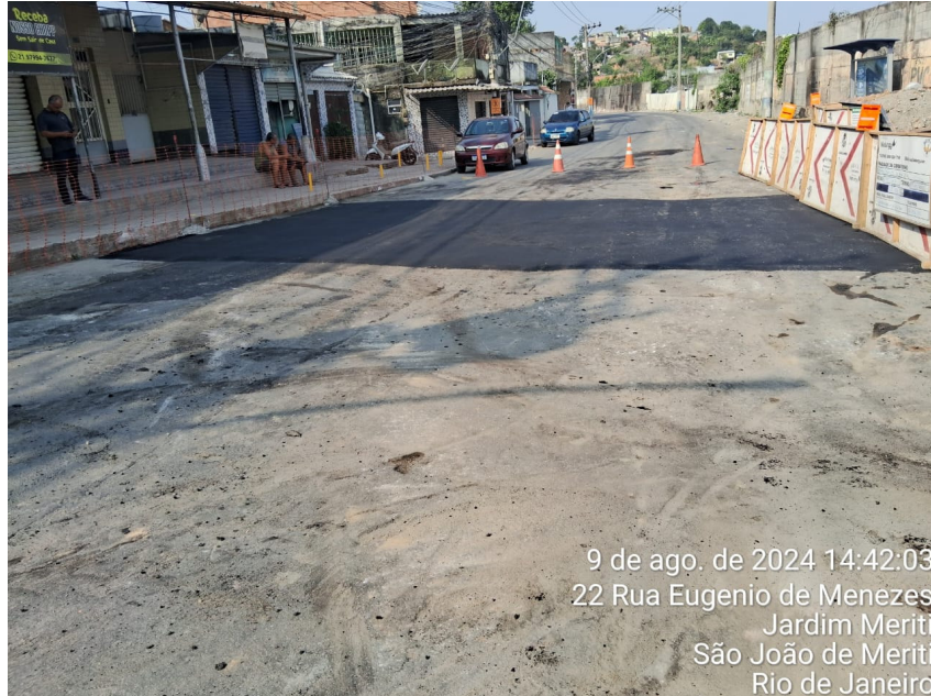
Foto 9: Trecho de recomposição refeita.
