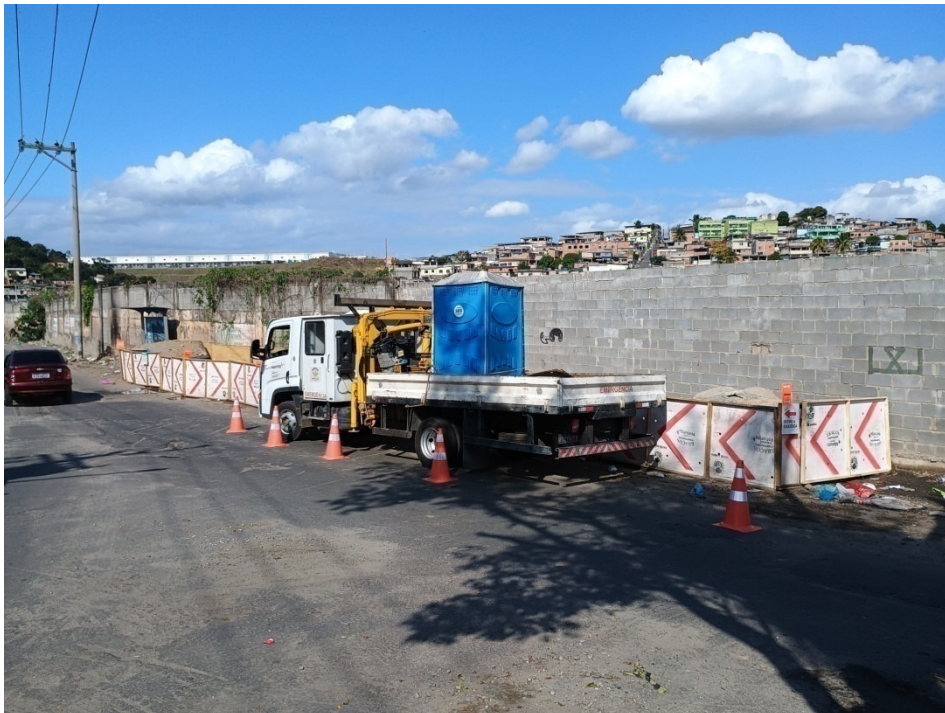
Foto 2: área de construção do galpão da empresa Prologis.
