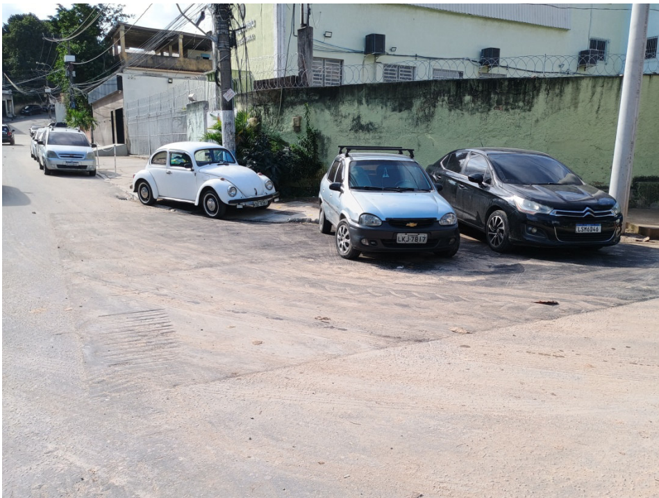
Foto 4: término da obra na Rua Sepetiba, 350.
