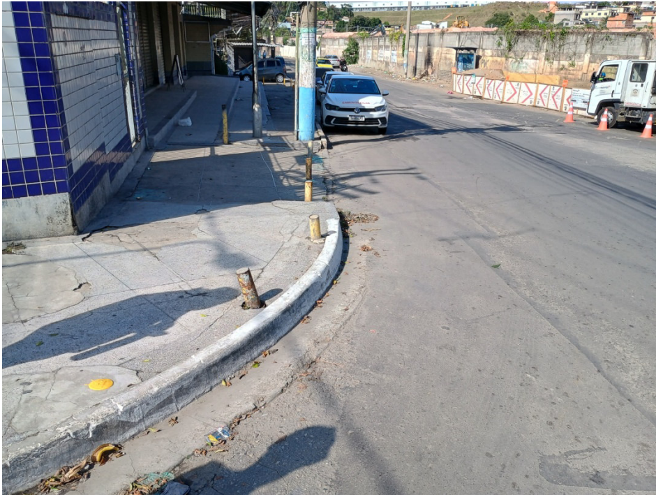
Foto 3: início da obra na Rua Eugênio Menezes, 278.
