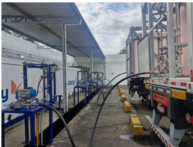
Foto 4: Carreta conectada à RCU.
