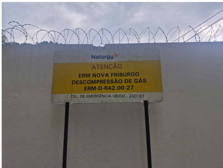
Foto 1: Placa de Identificação da estação.
