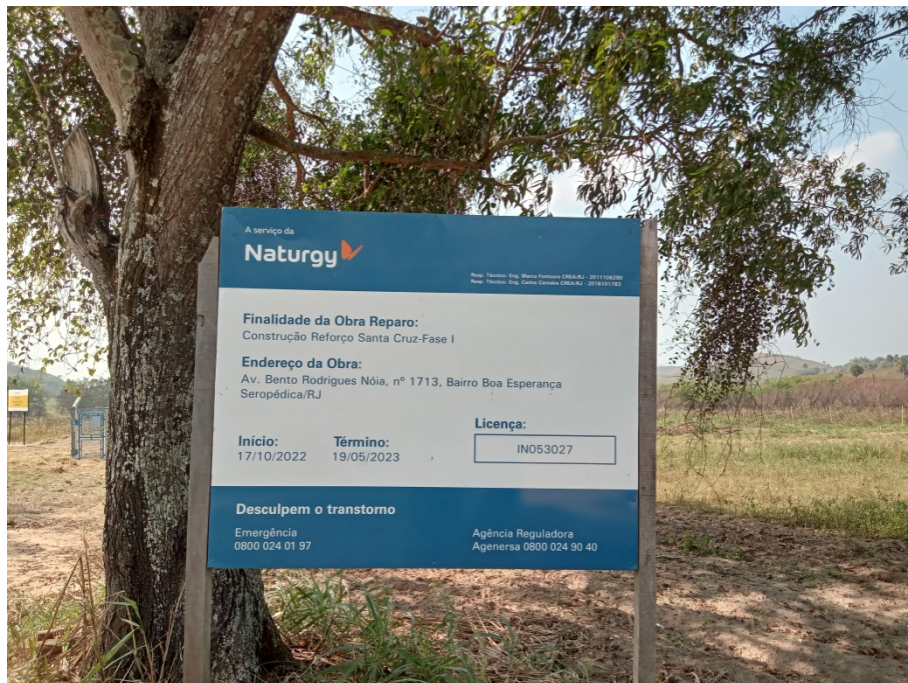
Foto 6: Identificação da obra de reforço realizada em substituição à rede antiga de Ø8".
