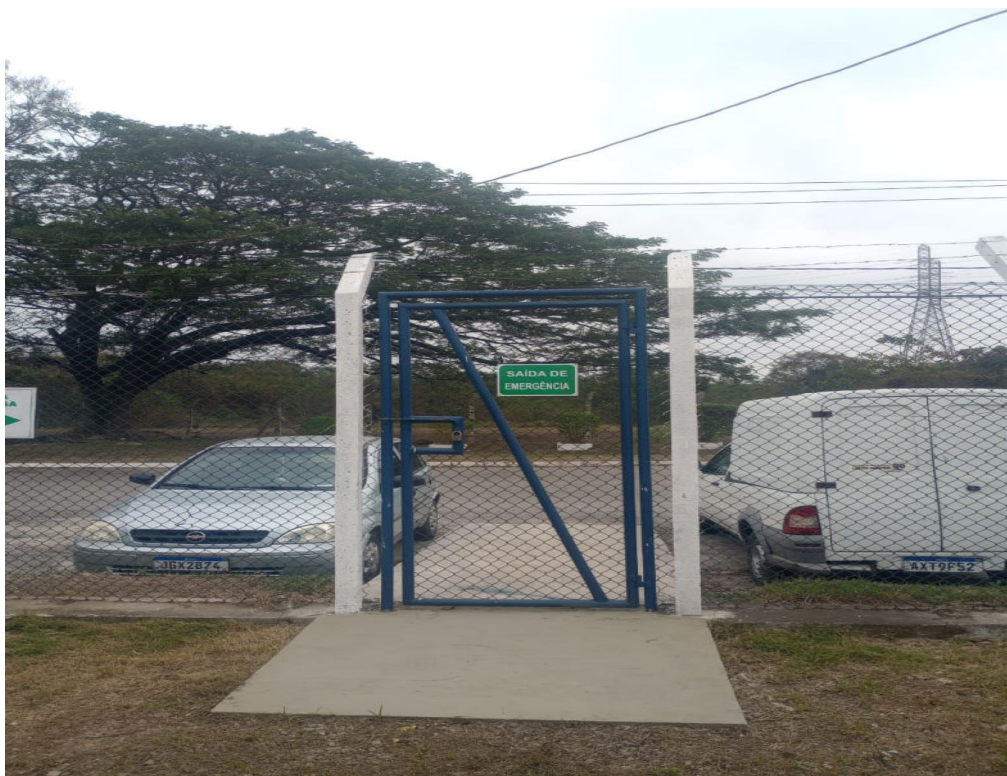
Foto 22: Reposição de placa de saída de emergência no portão.
