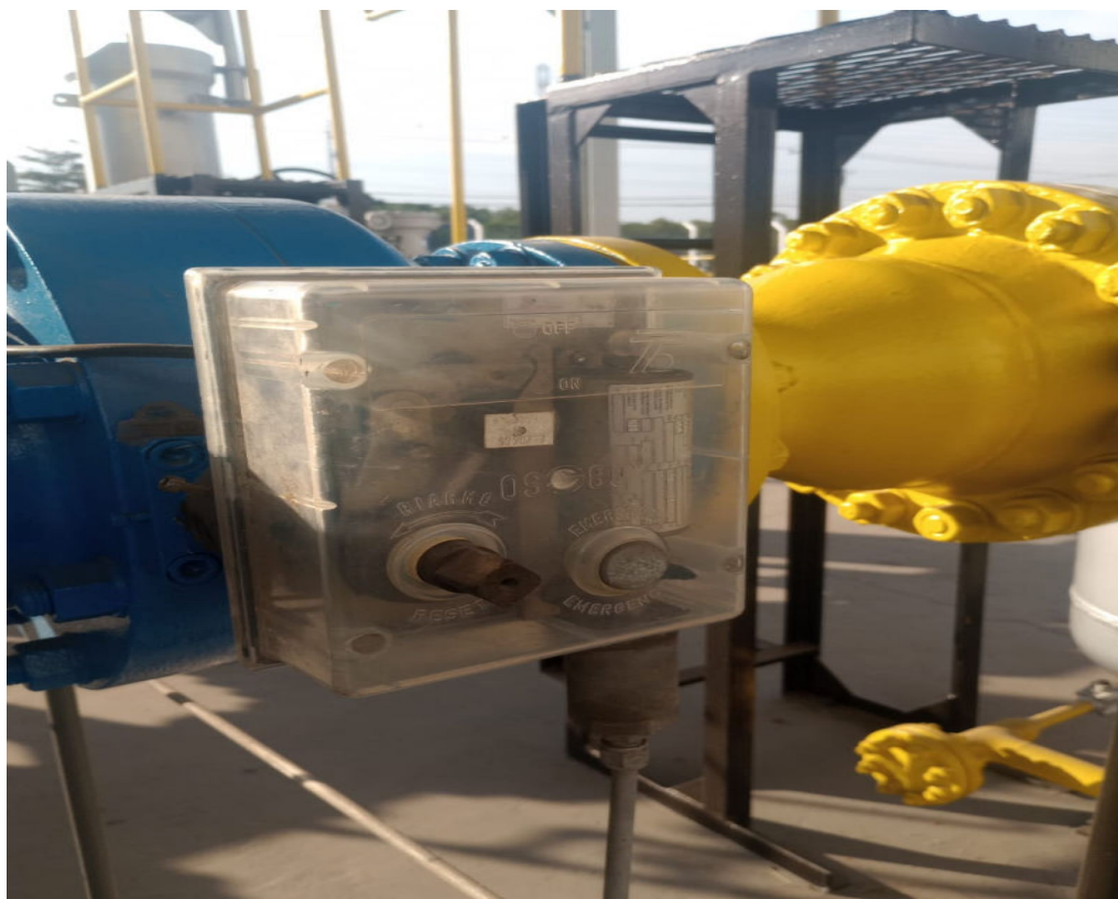
Foto 23: Nova caixa de acrílico, que protege componentes do regulador.
