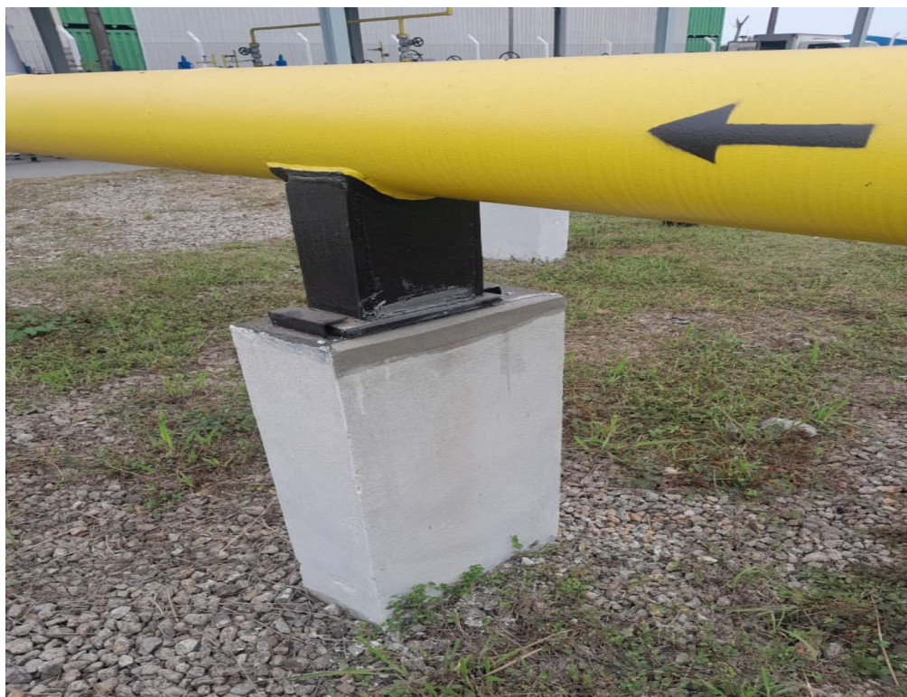
Foto 20: Ponto consertado no suporte que sustenta a tubulação.
