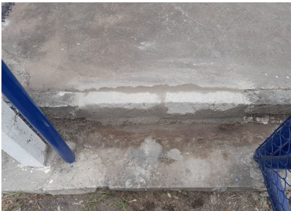
Foto 16: Ponto consertado em estrutura que acomoda válvula subterrânea.
