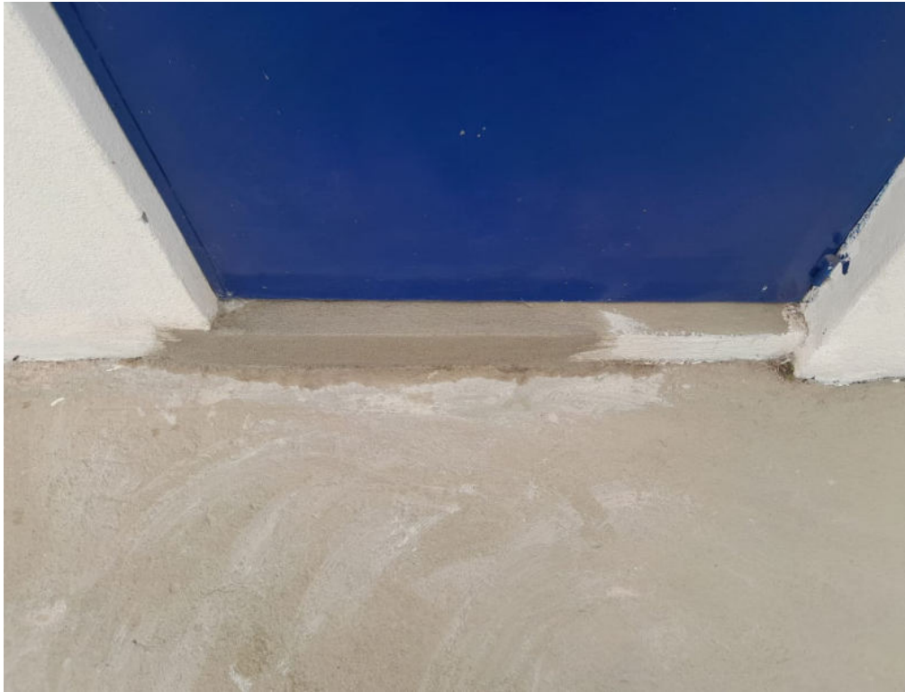
Foto 17: Ponto consertado na entrada da construção que está servindo como almoxarifado de peças.
