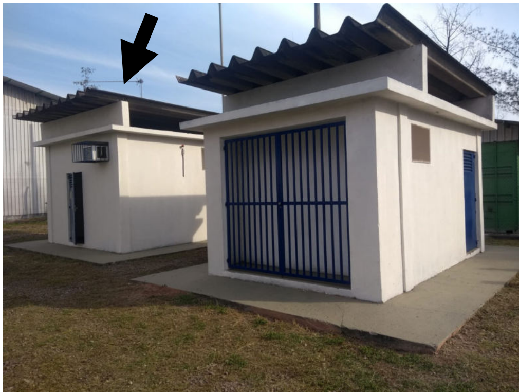
Foto 6: Local de acondicionamento do sistema de telemetria.
