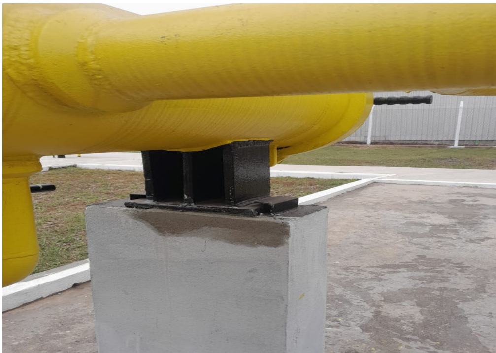
Foto 21: Ponto consertado no suporte que sustenta a tubulação.
