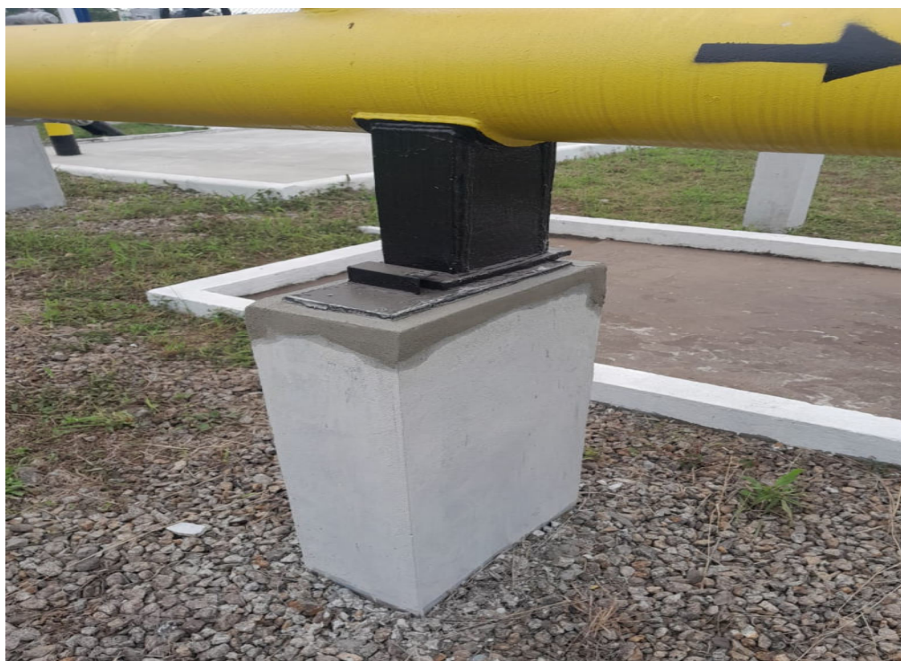
Foto 19: Ponto consertado no suporte que sustenta a tubulação.
