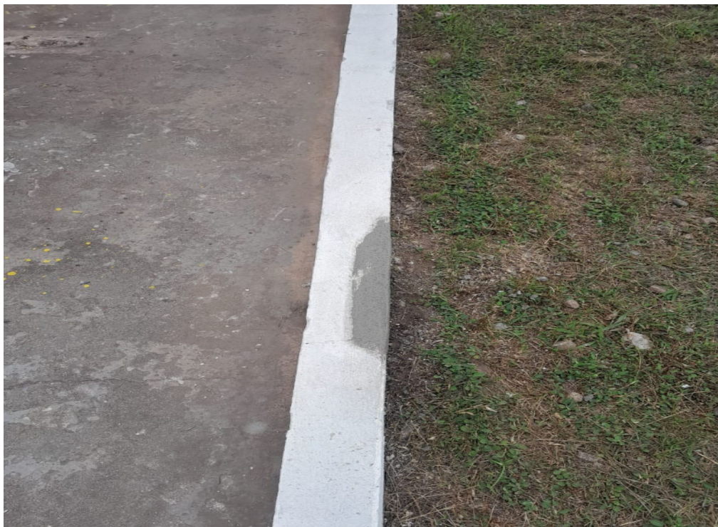
Foto 18: Ponto consertado no caminho cimentado.
