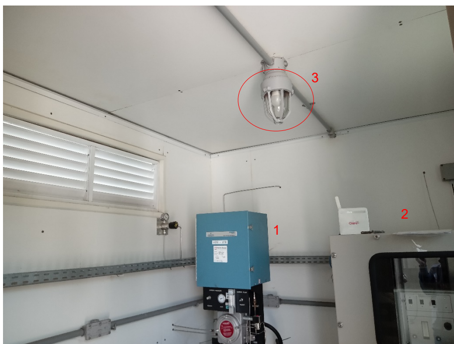
Foto 13: Cromatógrafo (1) e analisador do odorante (2) - lâmpada danificada (3).
