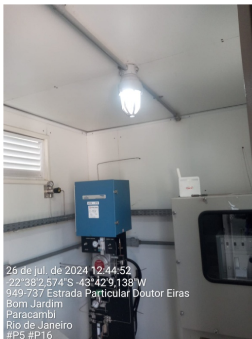
Foto 17: Adequação da iluminação da sala de cromatografia.
