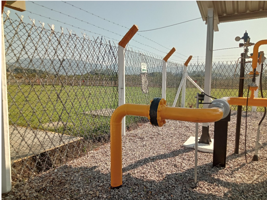
Foto 3: Linha de entrada do gás a partir da NTS.
