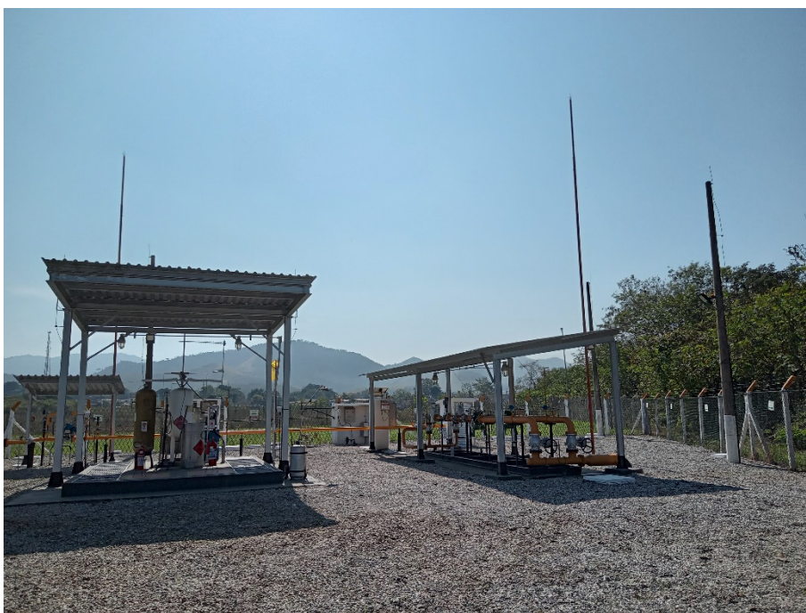
Foto 15: Vista das estações de odorização e regulagem e medição.
