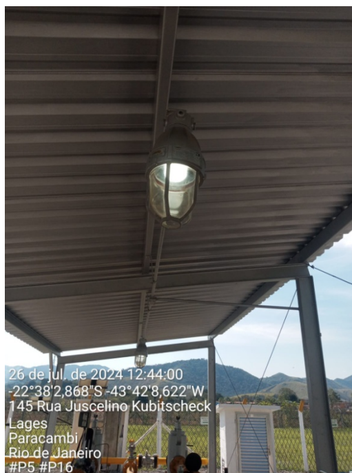
Foto 18: Adequação da iluminação da estação.
