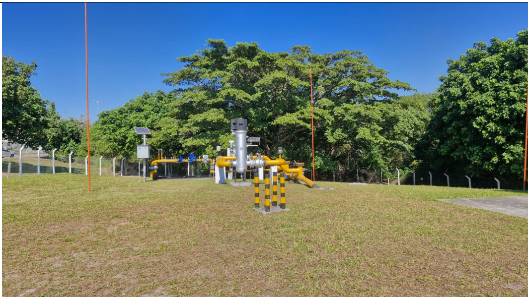
Foto 1: Vista da estação na entrada.
