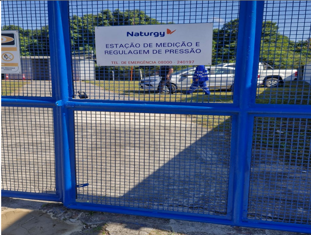
Foto 10: Entrada da Estação e placa de identificação.
