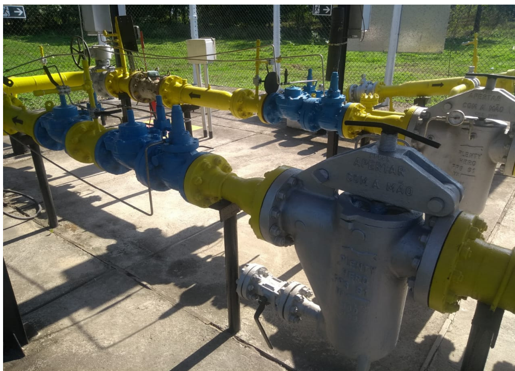
Foto 5: Reguladores e filtros das linhas principal e auxiliar.
