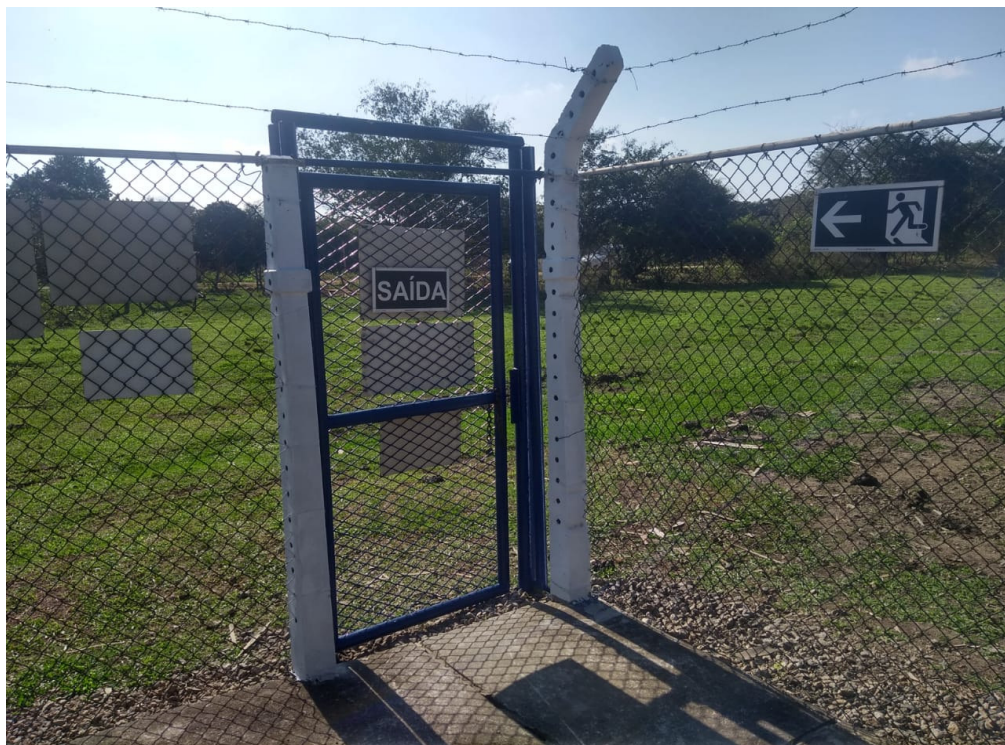
Foto 10: Sinalização para rota de fuga.
