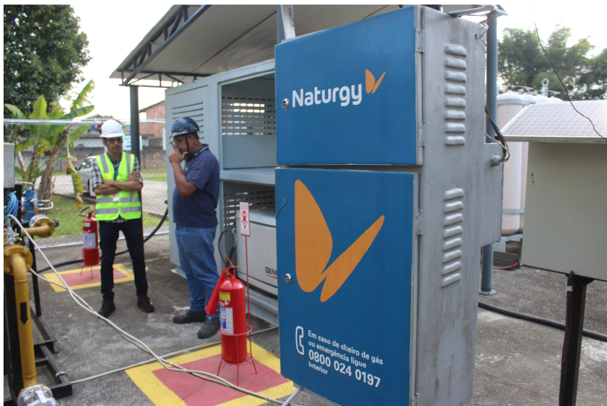
Foto 9: Sistema de Telemetria.
