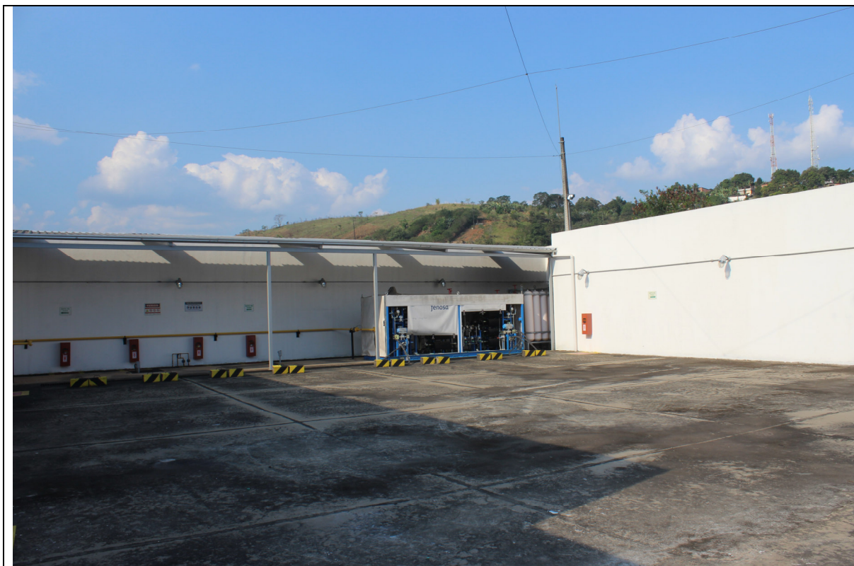
Foto 13: Visão geral da estação de descompressão.
