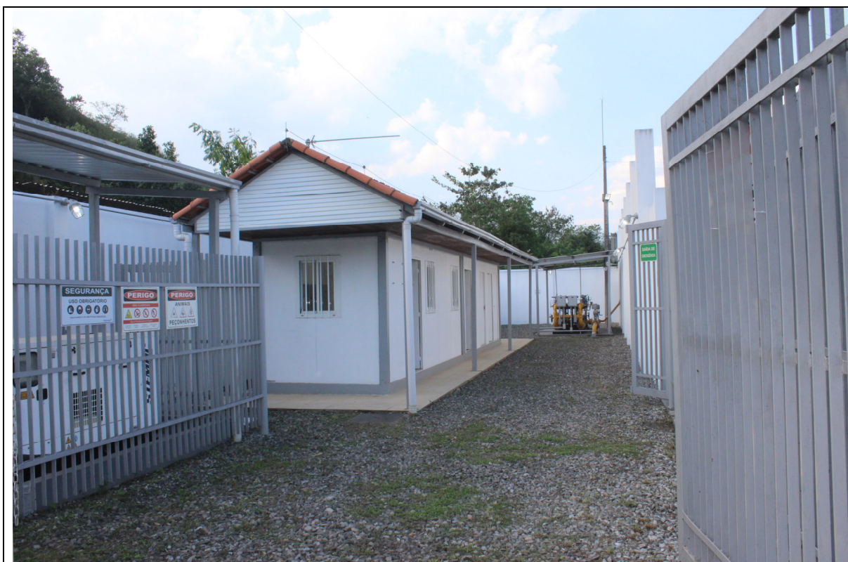
Foto 3: Vista geral da estação
