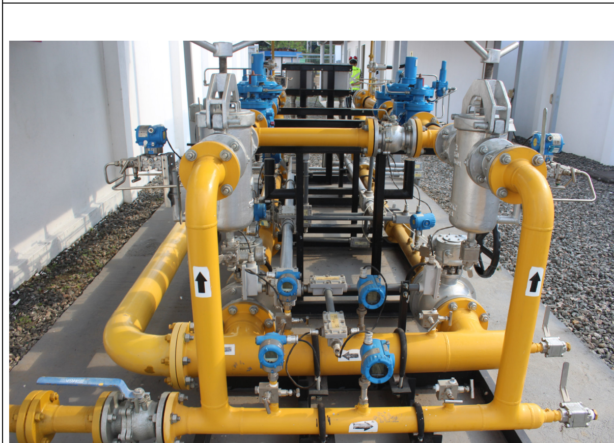
Foto 11: Visão da estação aérea.
