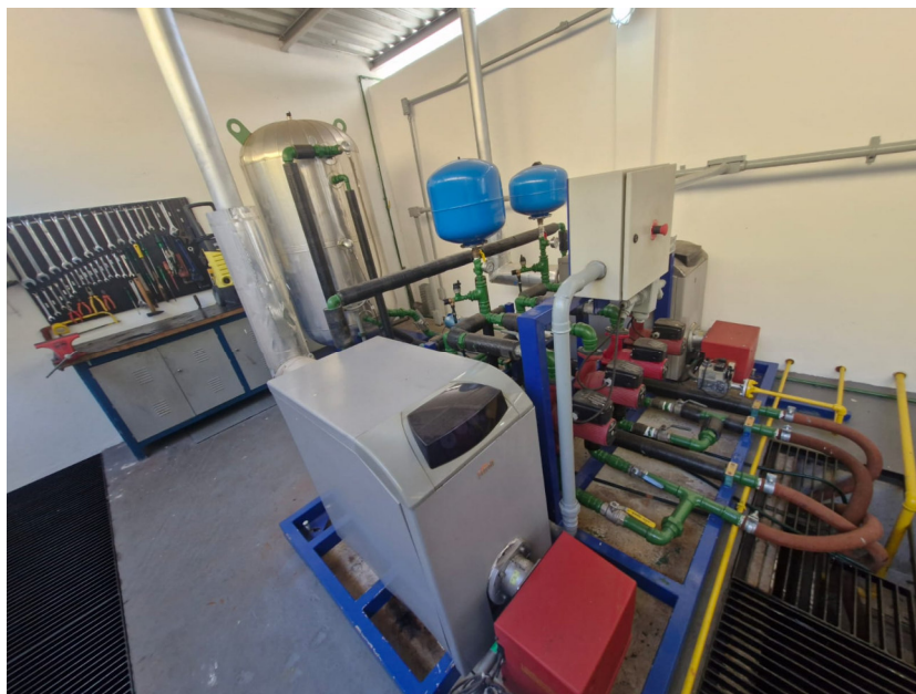
Foto 8: Aquecedores e tanque de estocagem de água.
