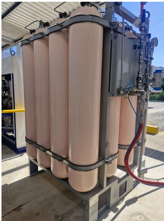
Foto 5: Sistema de estocagem do gás natural comprimido.
