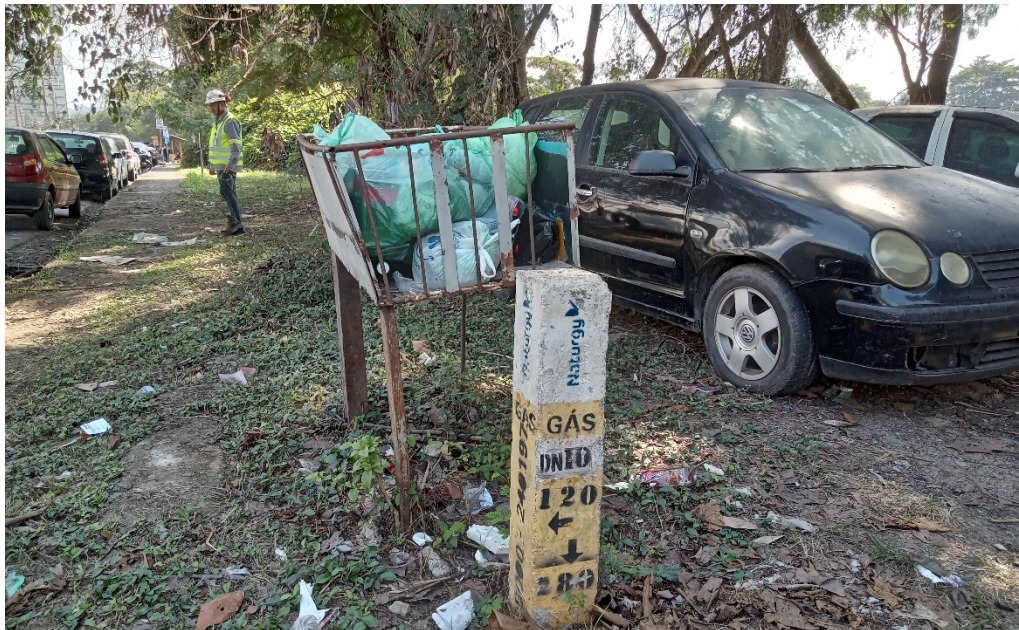
Foto 9: Marco vertical do gasoduto que segue para a CSN.
