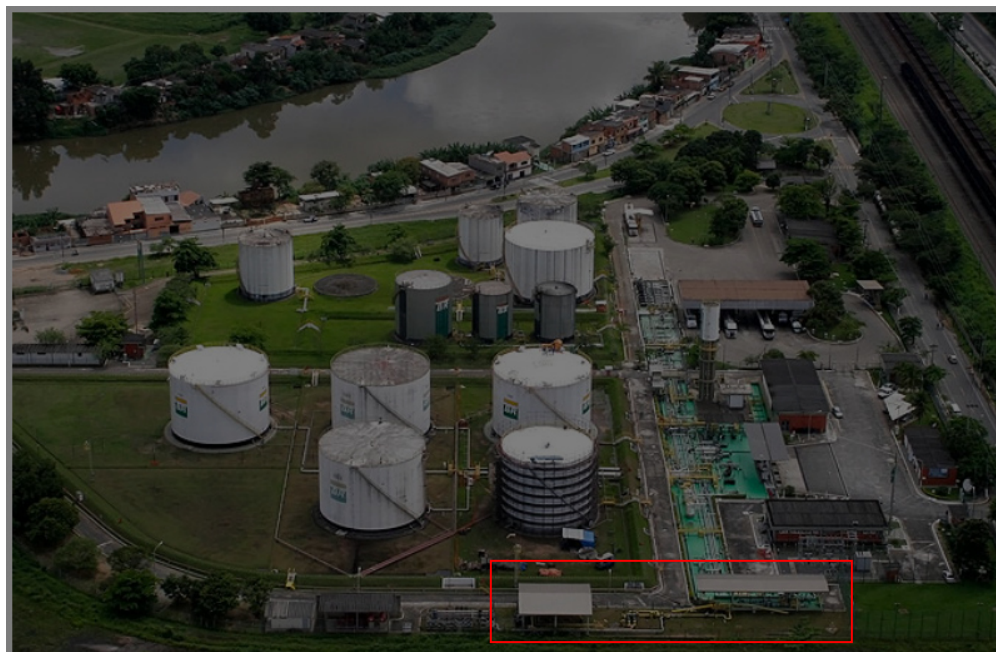
Foto 14: TEVOL – City Gate NTS (interior do retângulo em vermelho). Fonte: Transpetro. Disponível em: https://transpetro.com.br/transpetro-institucional/nossas-atividades/dutos-e-terminais/terminais-terrestres/volta-redonda-rj.htm . Acesso em 22 de julho de 2024.
