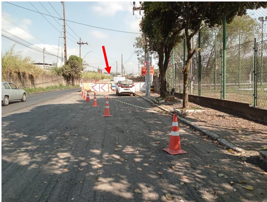
Foto 6: Obra de remanejamento de estação subterrânea na Avenida Integração.
