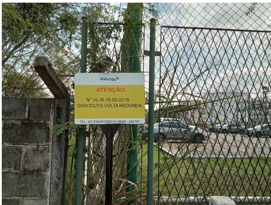
Foto 3: Placa de sinalização do gasoduto.
