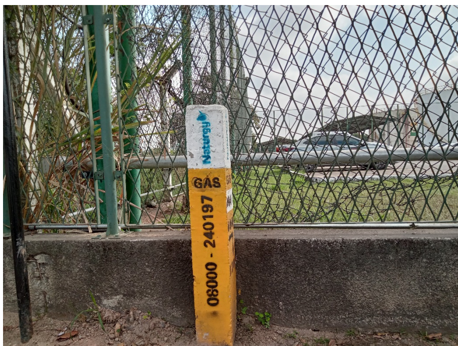
Foto 2: Marco vertical indicando presença de rede de gás enterrada.
