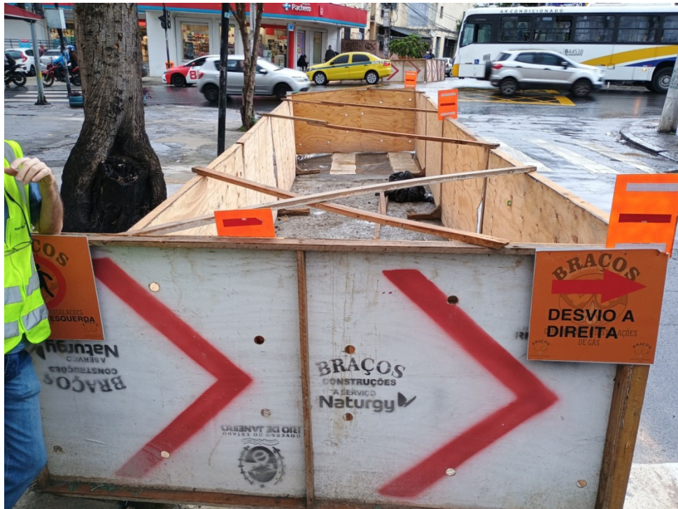
Foto 3: trecho de interligação por método destrutivo isolado.
