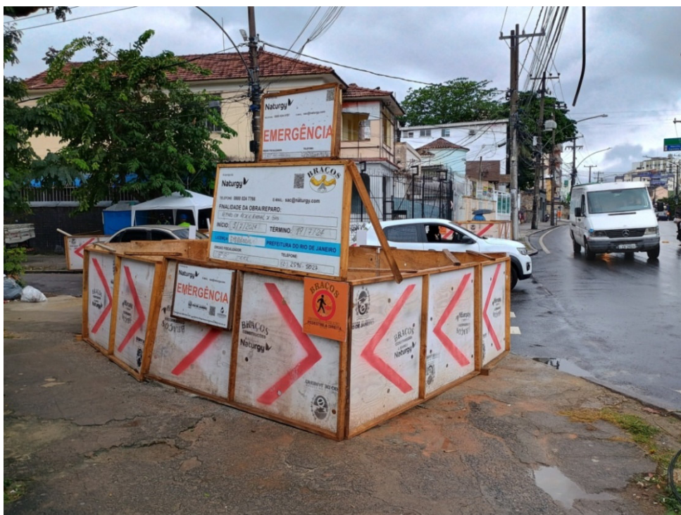
Foto 1: Início da obra na esquina da Rua Dias da Cruz com a Rua Alberto Leite.
