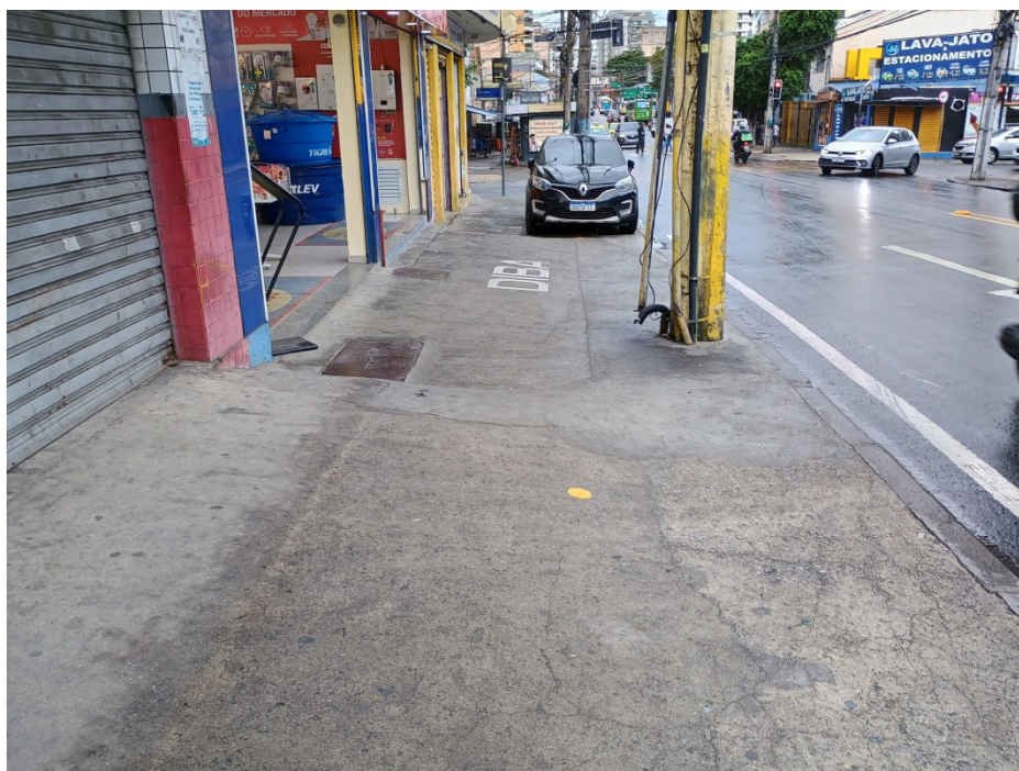
Foto 2: Término da obra na esquina da Rua Dias da Cruz com a Rua Souza Aguiar.
