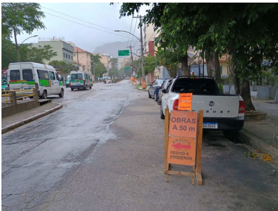
Foto 2: início da obra na Rua Intendente Cunha Menezes, 229.
