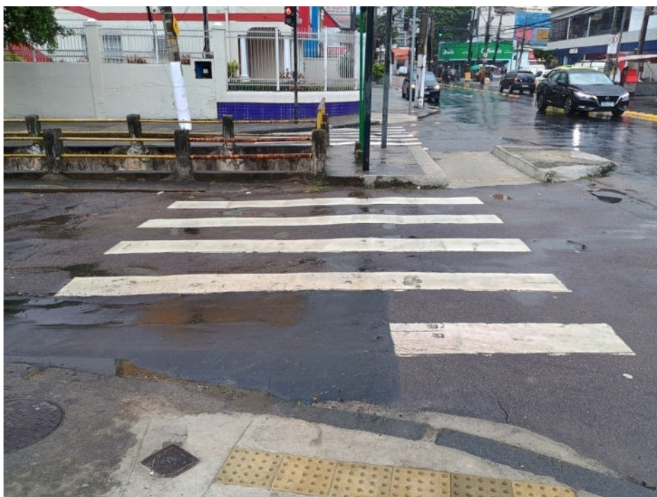
Foto 3: final da obra na esquina com a Rua Dias da Cruz.
