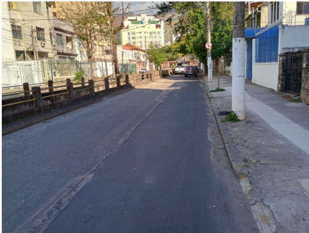
Foto 8: correção da recomposição verificada na segunda vistoria.
