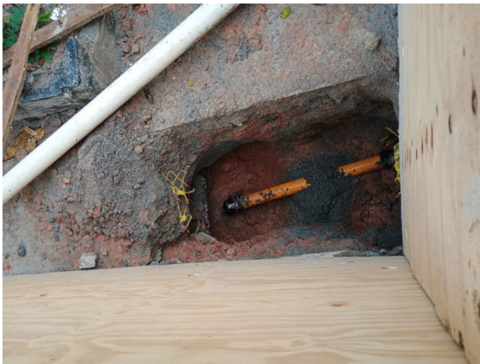
Foto 1: tubulação assentada por método destrutivo.
