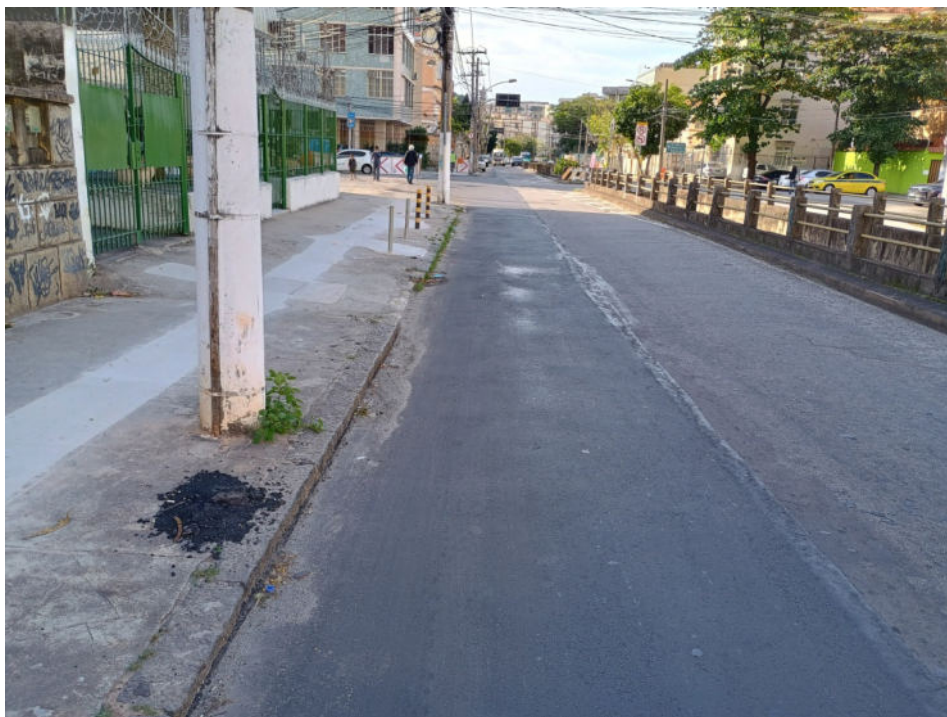
Foto 9: correção da recomposição verificada na segunda vistoria.
