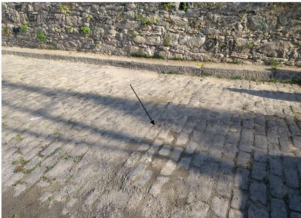
Foto 1: Recomposição definitiva na travessia da via, em frete ao número 228.
