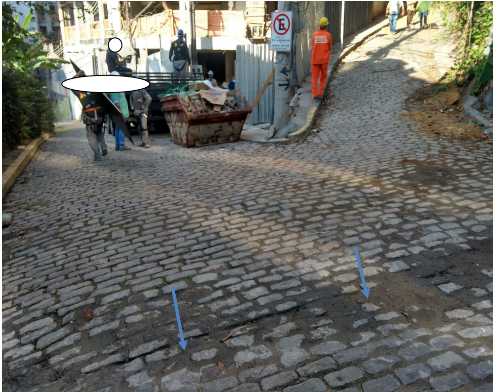
Foto 5: Recomposição definitiva na travessia da via, em frete ao número 146.
