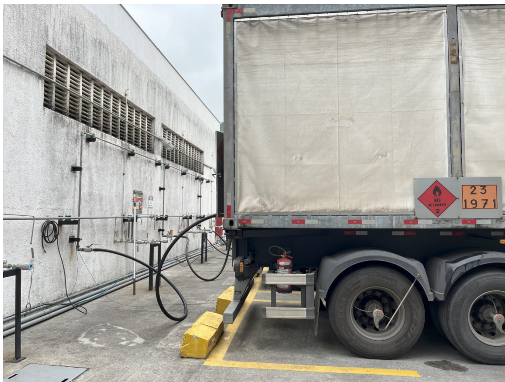
Foto 3: Abastecimento dos cilindros nas carretas.
