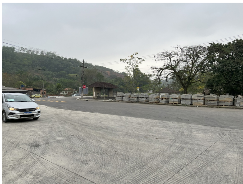
Foto 12: Via de entrada da estação.
