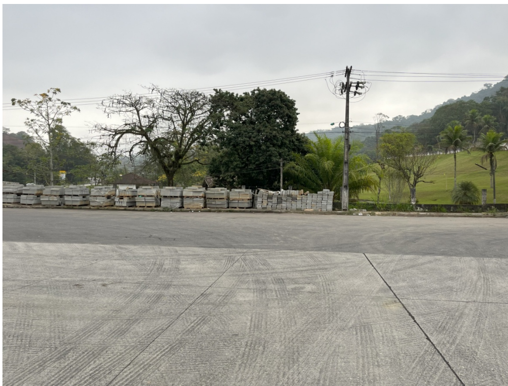
Foto 11: Via de entrada da estação.
