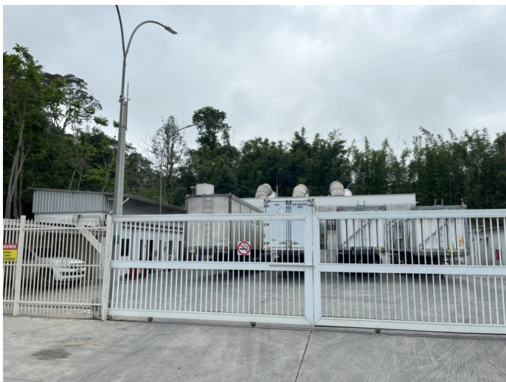
Foto 2: Vista geral da estação.
