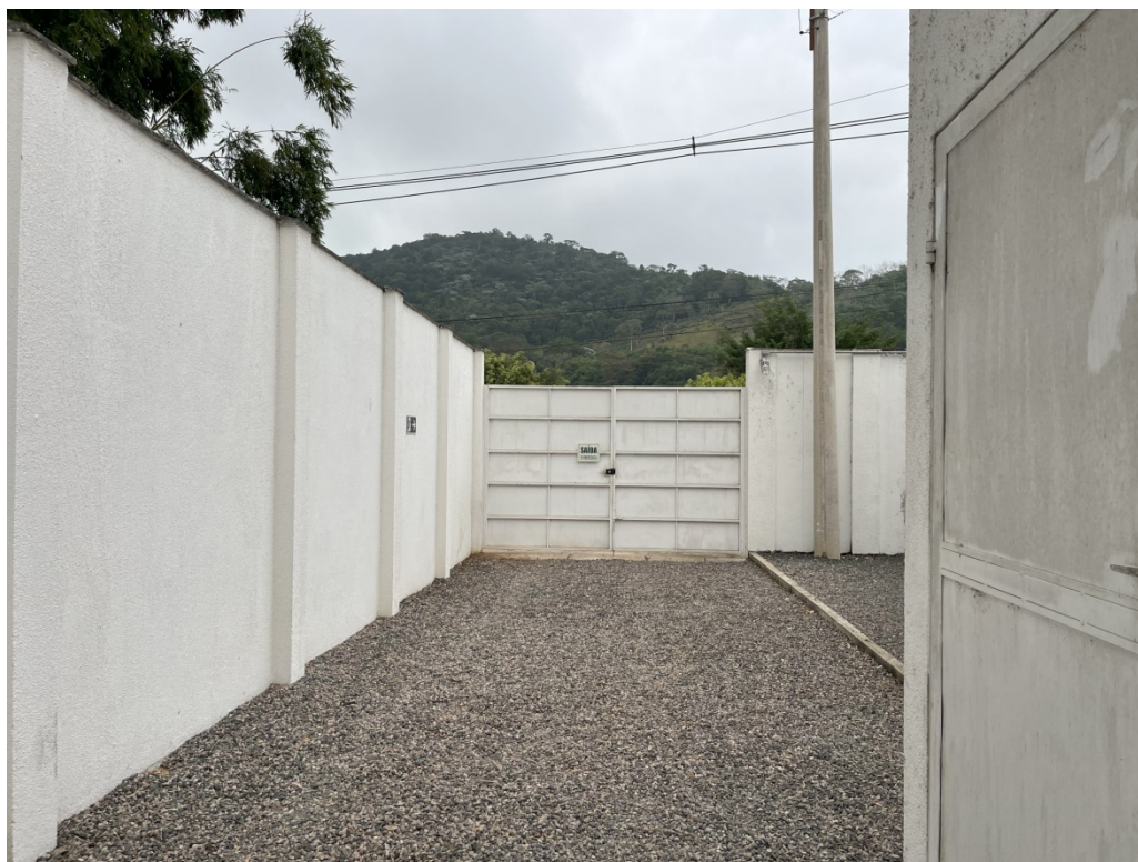
Foto 7: Placa de rota de fuga e saída de emergência.
