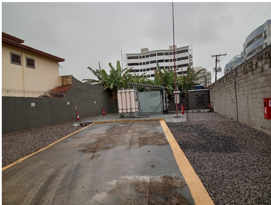
Foto 3: Vista frontal da estação.
