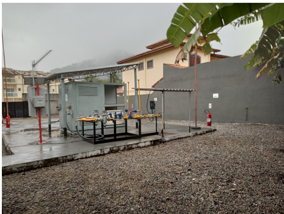
Foto 4: Vista dos fundos da estação.
