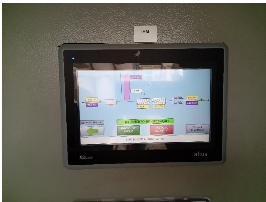
Foto 11: Interface homem-máquina da Unidade de Redução e Controle.
