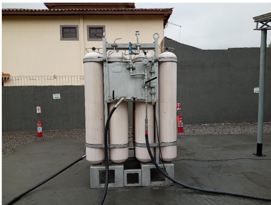
Foto 5: Sistema de estocagem do gás natural comprimido.
