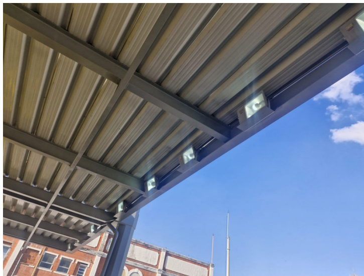
Foto 12: Iluminação acesa da Estação.
