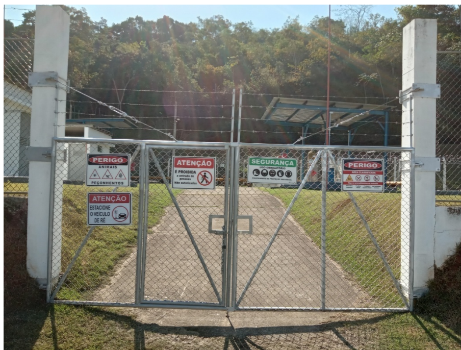
Foto 1: Entrada da estação e sinalização de segurança.
