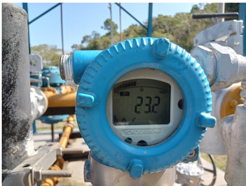
Foto 9: Indicação da pressão na linha de entrada da ERM 2º corte.
