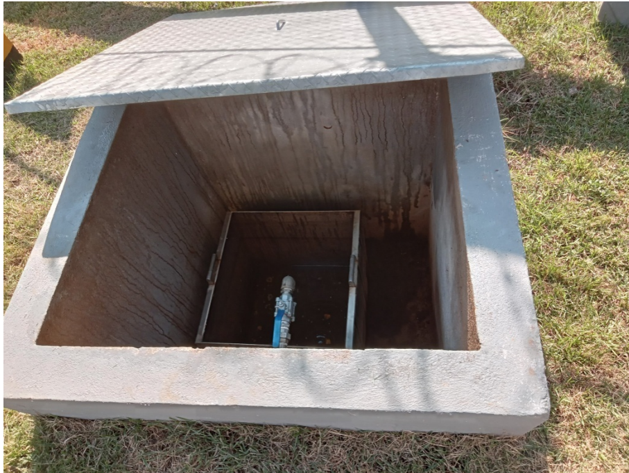
Foto 17: Caixa para contenção de mercaptana com presença de água.
