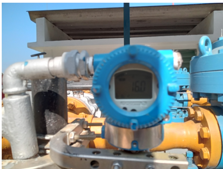
Foto 10: Indicação da pressão na linha de saída da ERM 2º corte.
