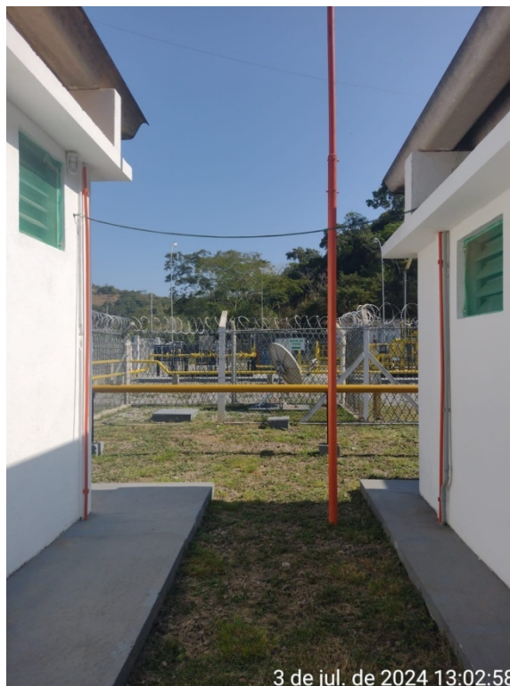
Foto 18: Cabos expostos sem proteção mecânica.
