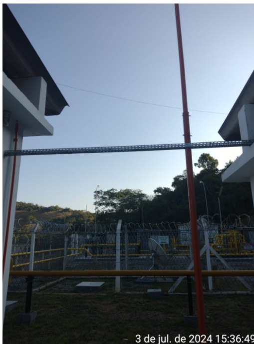
Foto 21: Adequação da condição de instalação de cabos aéreos.
