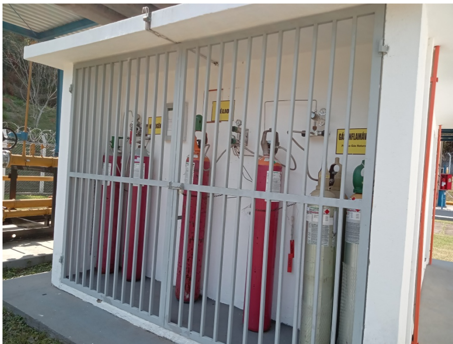
Foto 13: Gases utilizados no processo de análise do sistema de cromatografia.
