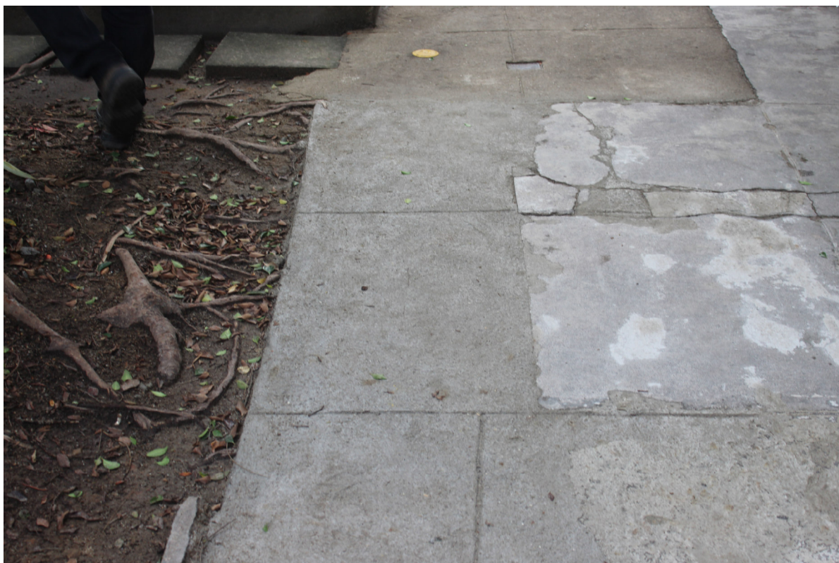
Foto 2: Recomposição na calçada.
