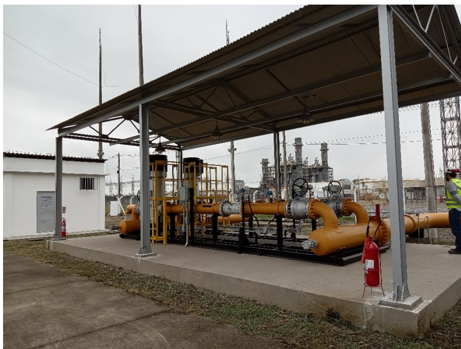
Foto 3: Estação de medição.
