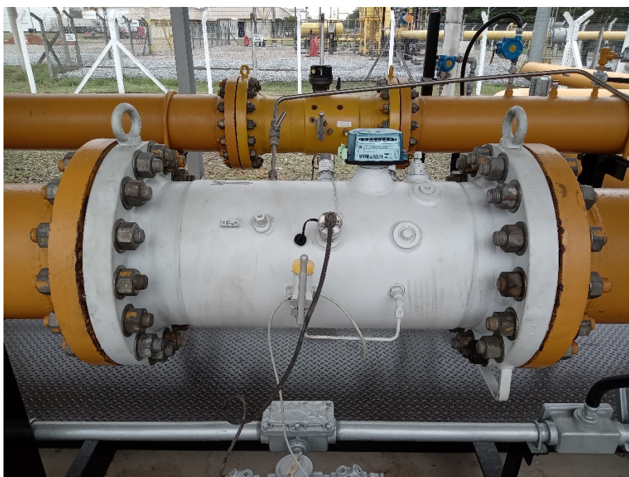
Foto 6: Medidor de vazão (Turbina).
