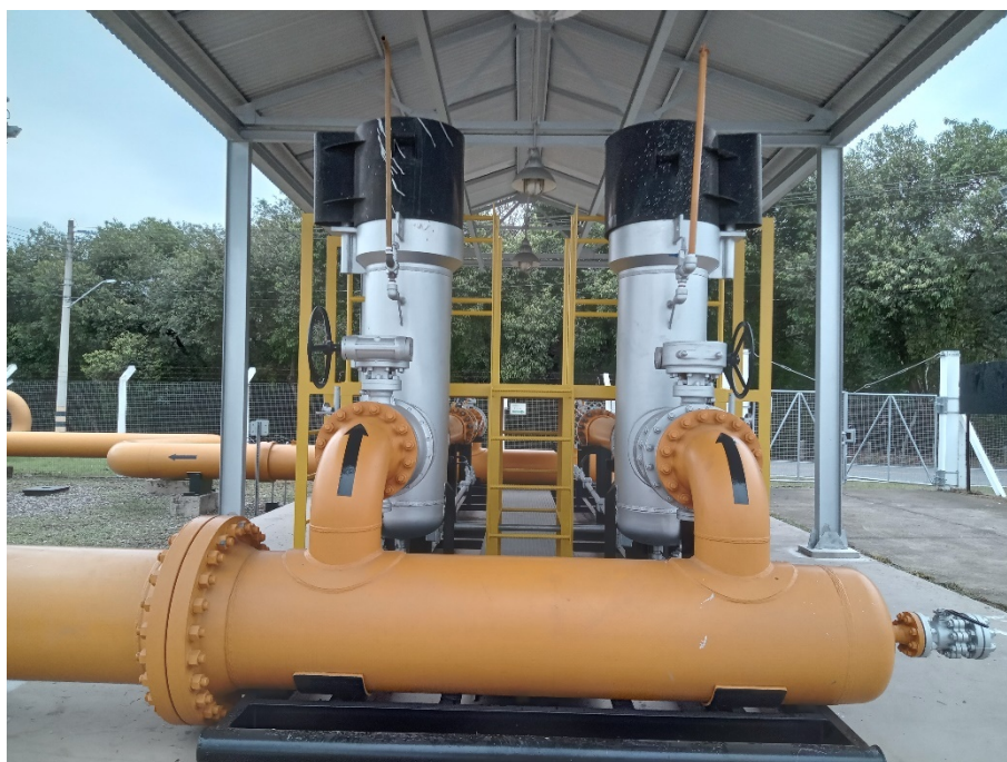
Foto 4: linha de entrada da estação.
