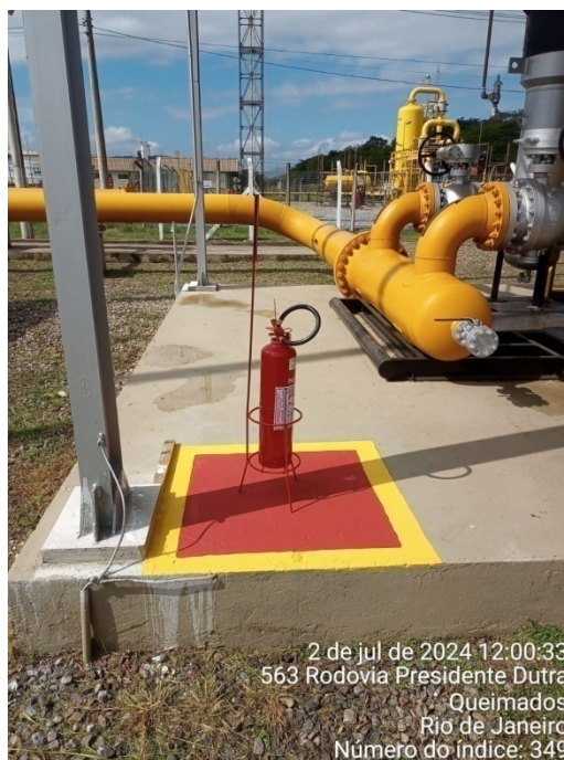
Foto 17: Adequação de pintura de área demarcada para localização do extintor de incêndio.
