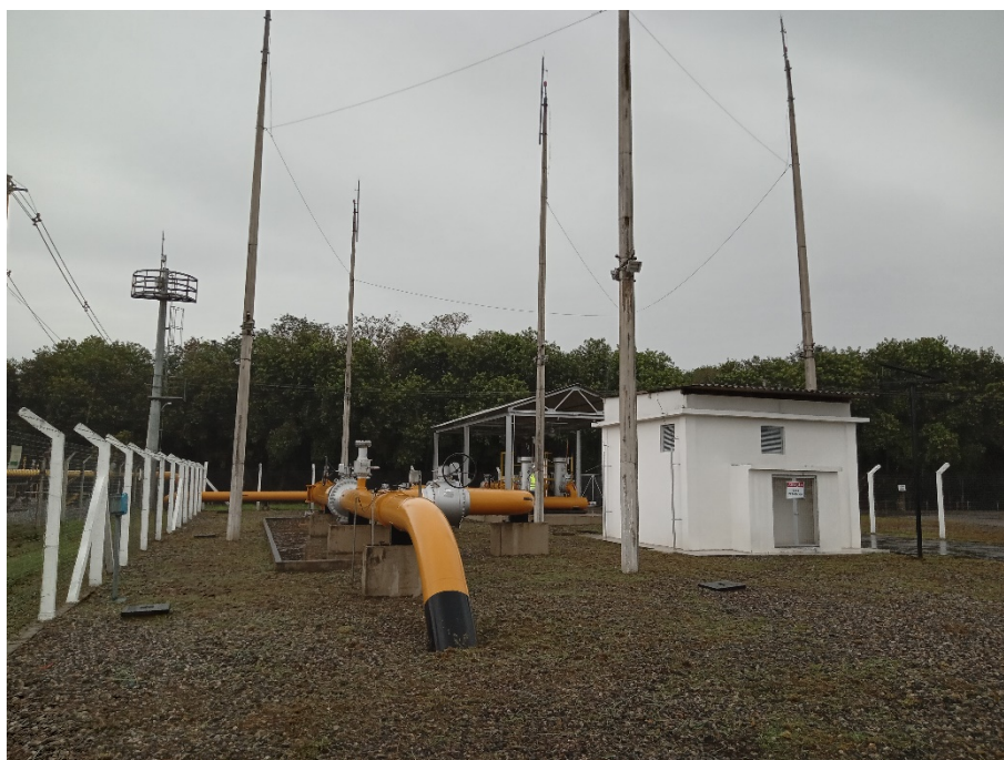
Foto 10: Sistema receptor de PIG.
