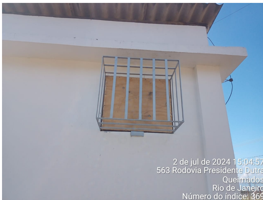
Foto 18: Adequação de vedação em abertura na parede da sala de comando e telemetria.
