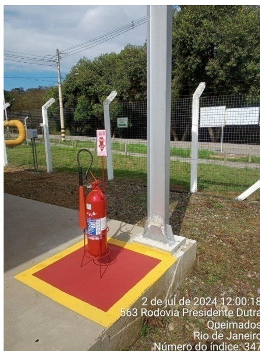
Foto 16: Adequação de pintura de área demarcada para localização do extintor de incêndio.
