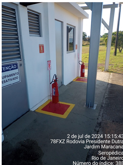
Foto 13: Adequação de pintura no piso demarcando a localização dos extintores.
