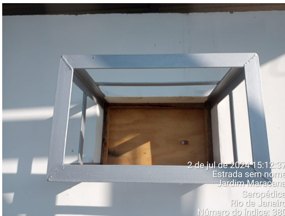
Foto 16: Vedação de abertura na parede da sala de comando.
