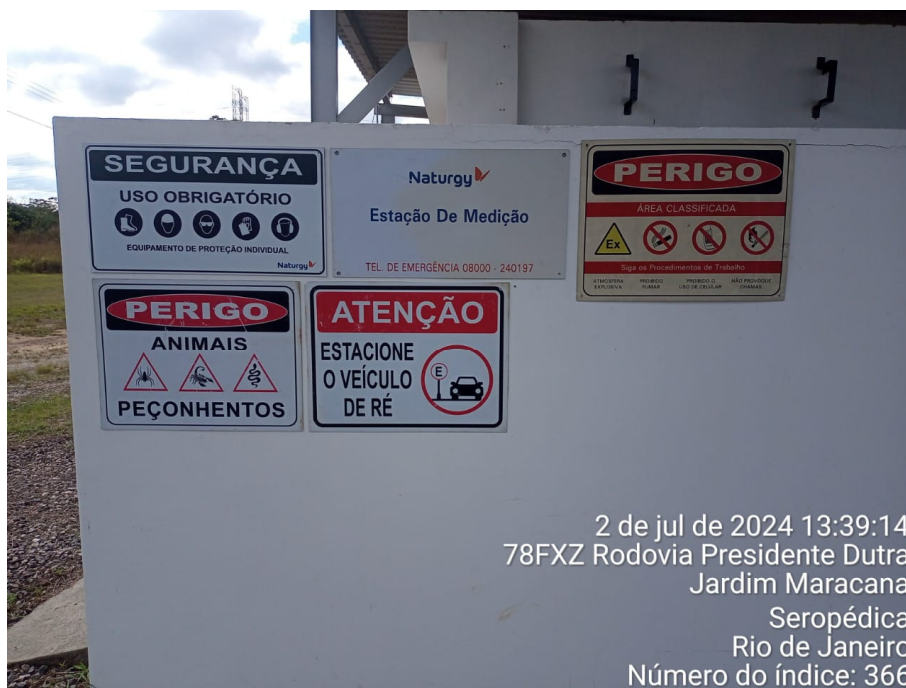
Foto 14: Adequação de placa de sinalização de segurança (área classificada).
