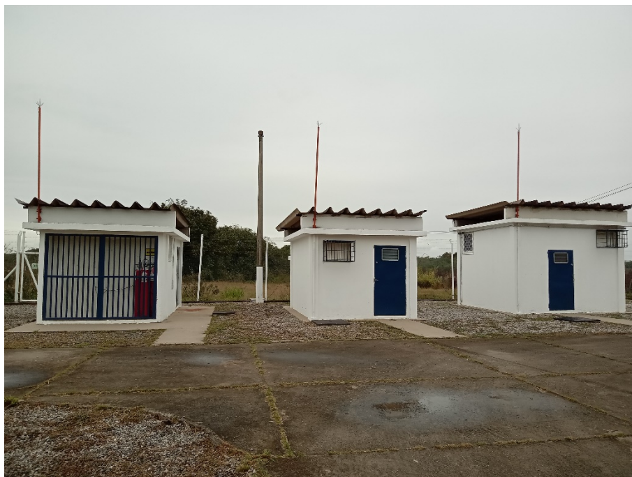
Foto 9: Sala de cromatografia, sala de comando e telemetria e sala elétrica.
