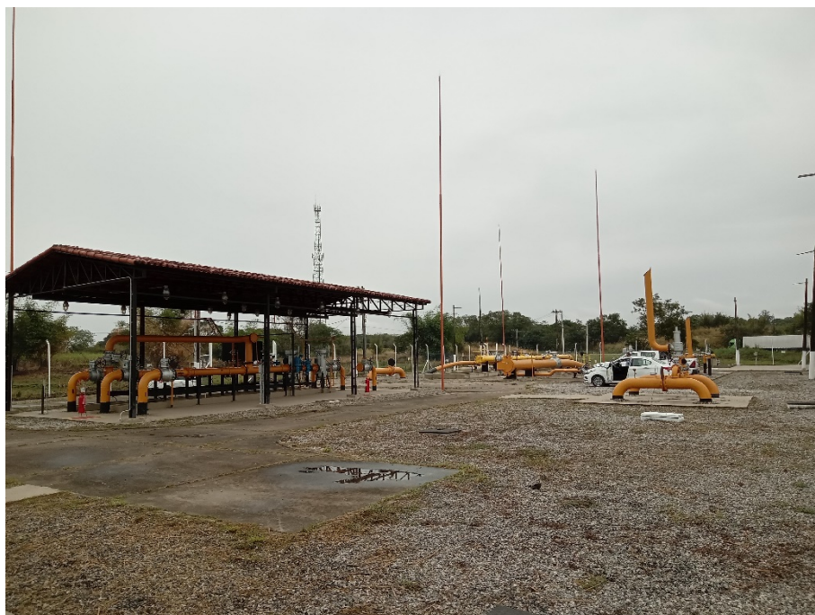
Foto 2: Vista geral da estação.
