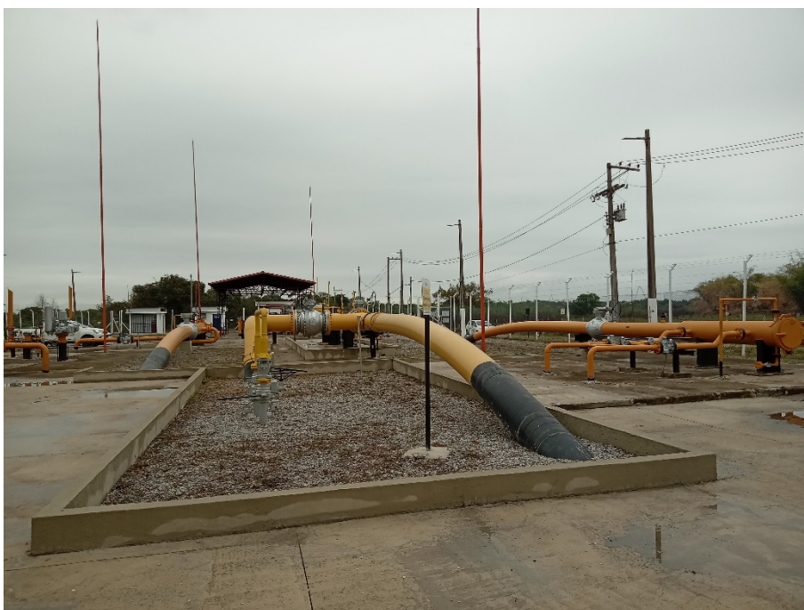
Foto 13: Sistema lançador e receptor de PIG.
