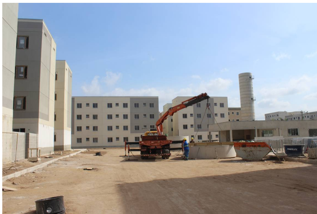
Foto 2: Área do condomínio ainda em construção.
