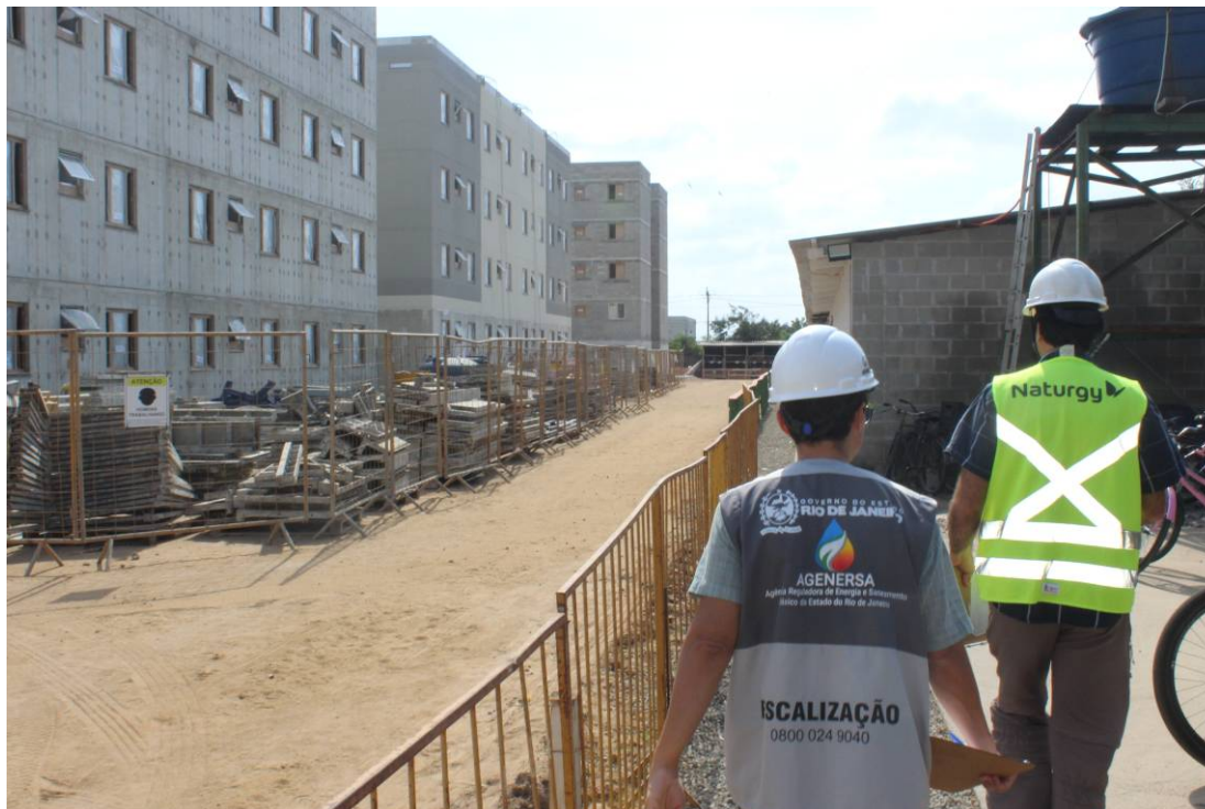
Foto 4: Equipe de fiscalização da AGENERSA em local de rede construída.
