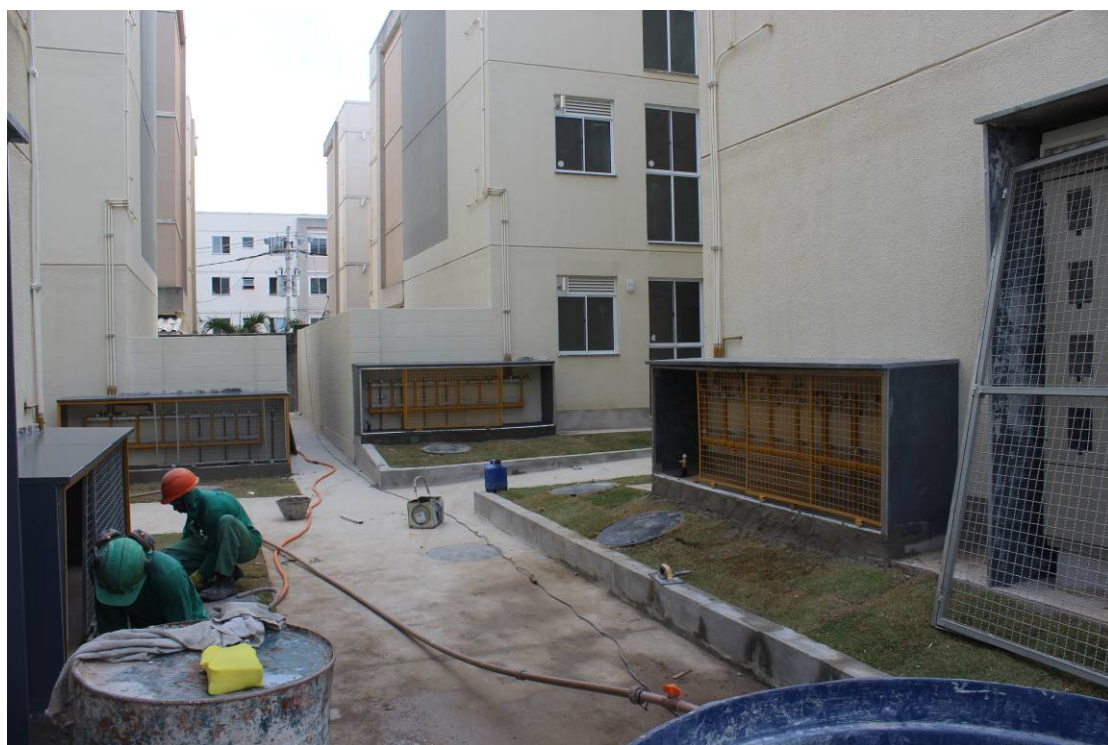
Foto 6: Abrigo dos medidores de gás e regulador de pressão em construção.
