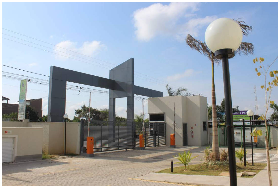
Foto 2: Portal do condomínio ainda em construção.
