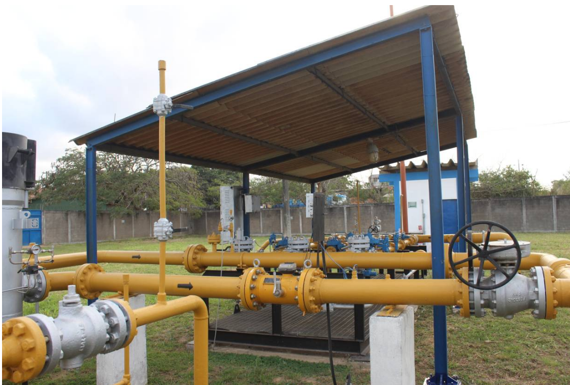
Foto 5: Estação aérea de Tapera.
