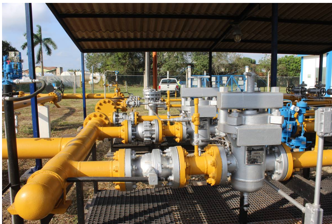
Foto 9: Medidor turbina da estação em cinza.
