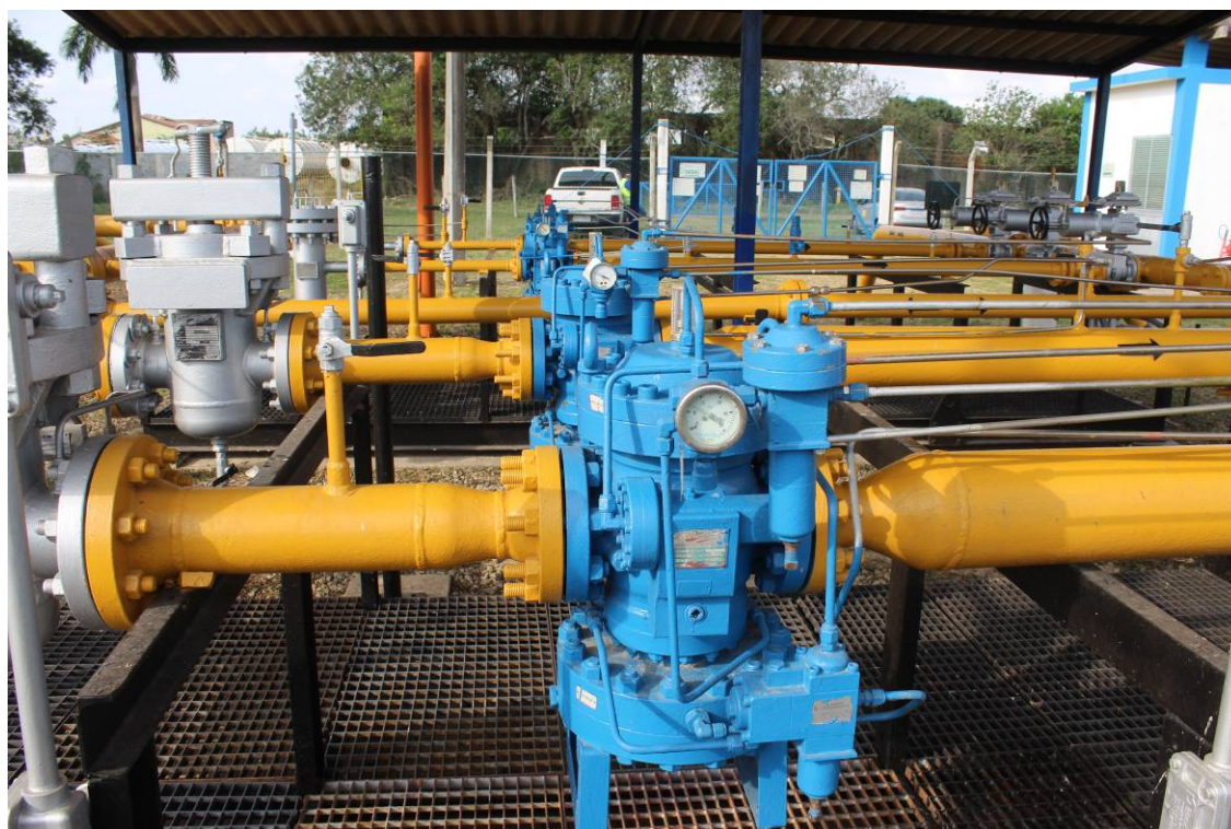
Foto 8: Regulador de pressão da estação.
