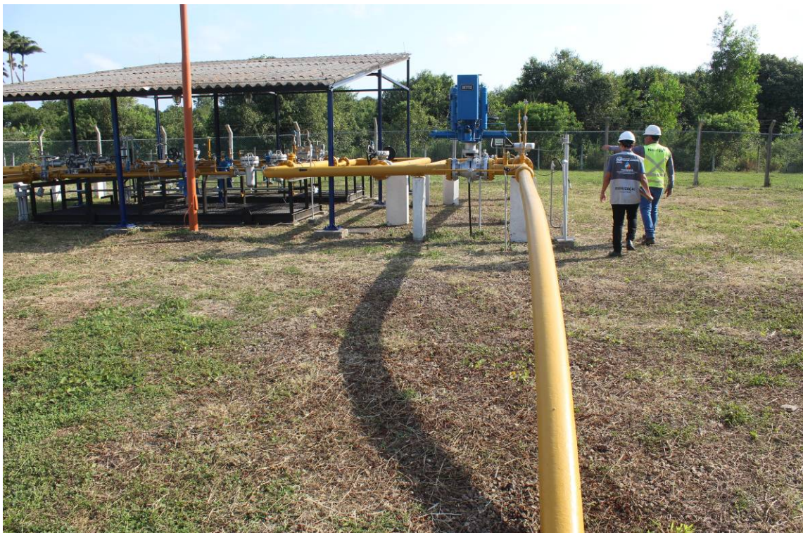
Foto 11: Canhão receptor de PIG da estação de Donana.
