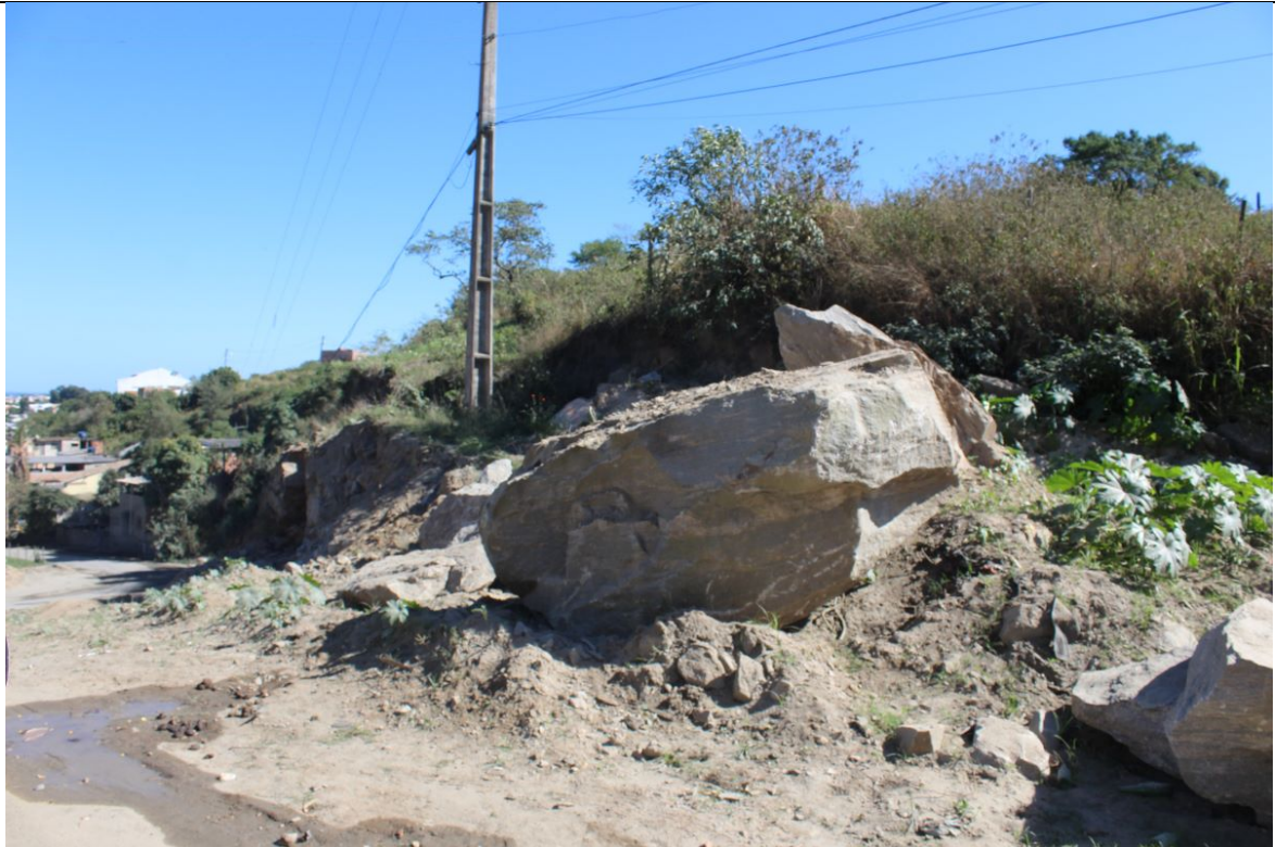
Foto 9: Estrada adjacente à pedreira.
