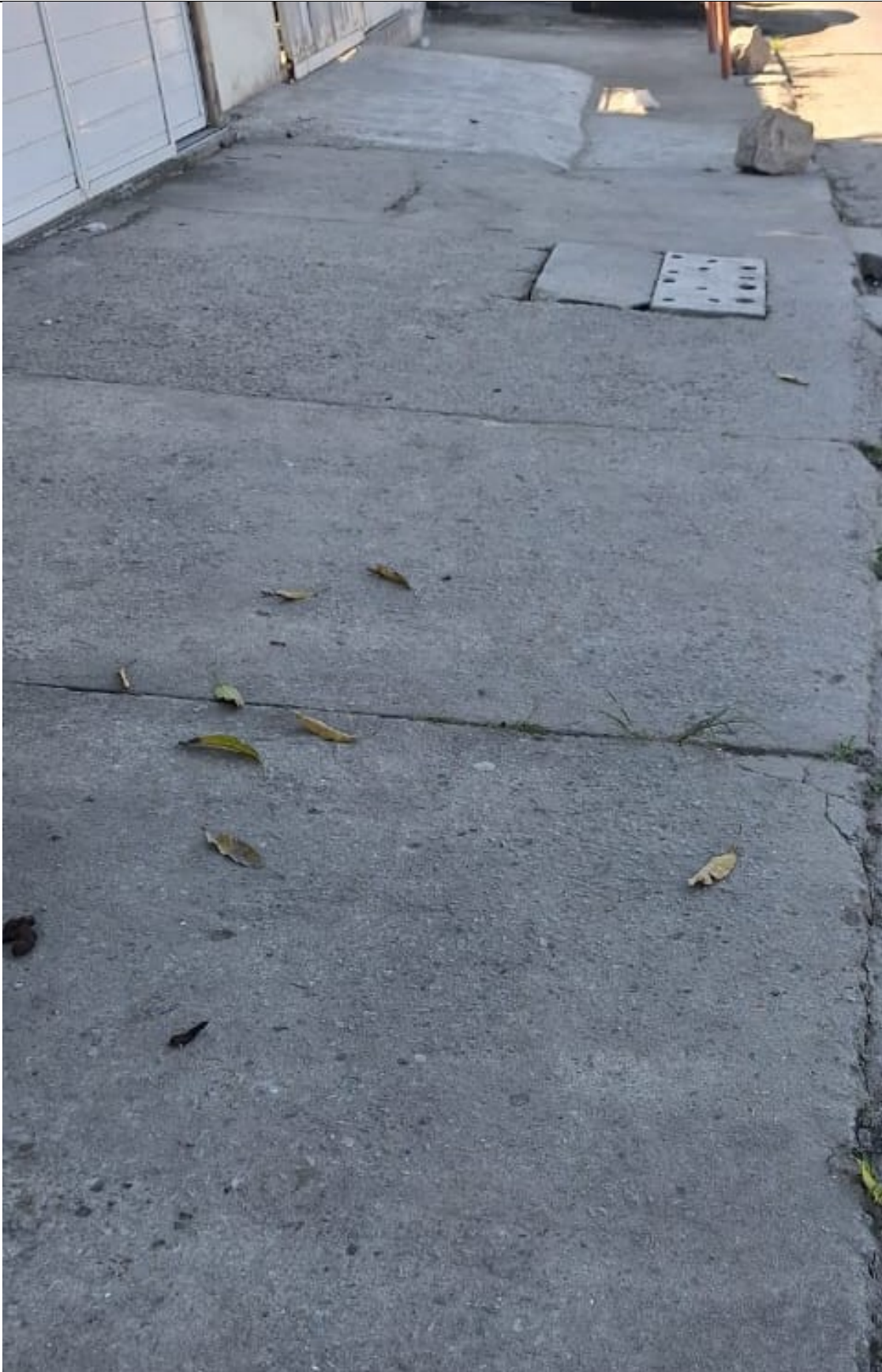
Foto 6: Marco plano horizontal já instalado no primeiro trecho.
