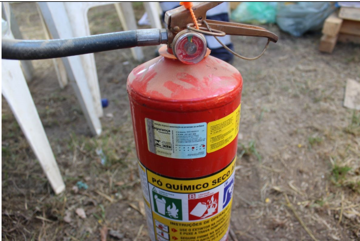
Foto 2: Extintores disponíveis e lacrados.
