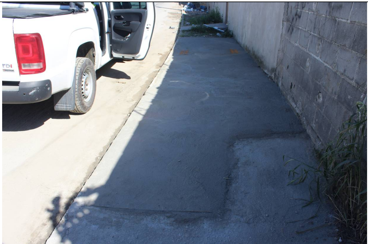
Foto 10: Trecho de reposição provisória.
