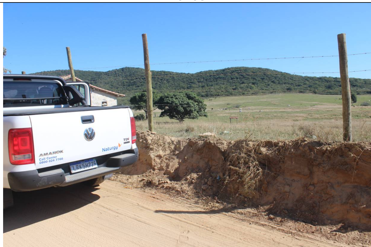
Foto 8: Segundo trecho da via onde são realizadas as obras de expansão.
