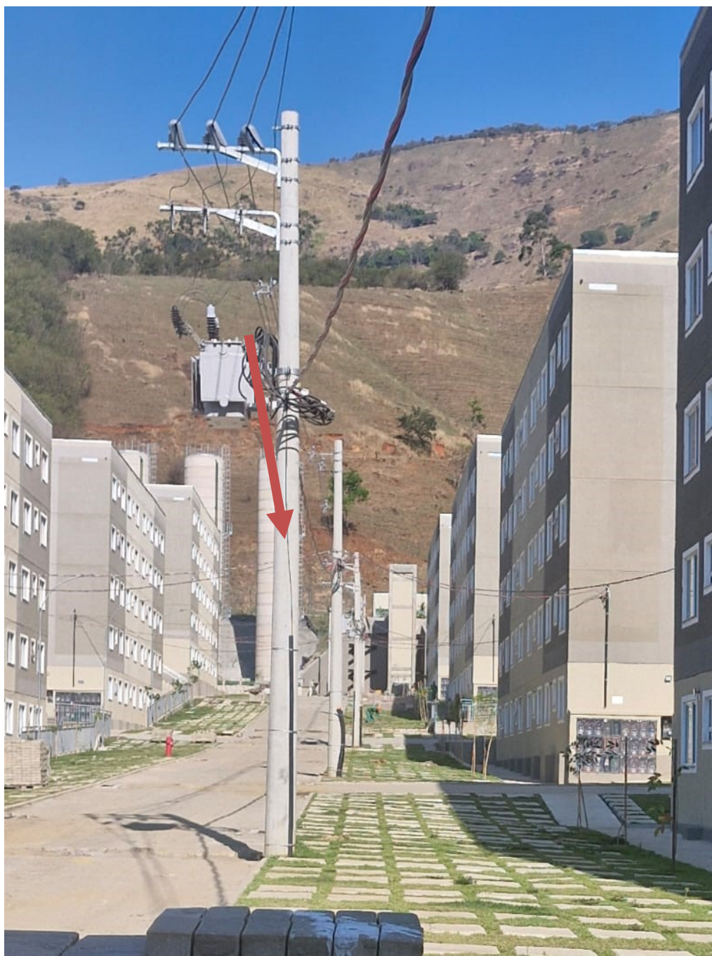
Foto 3: Trecho já assentado que leva o gás aos diversos blocos.
