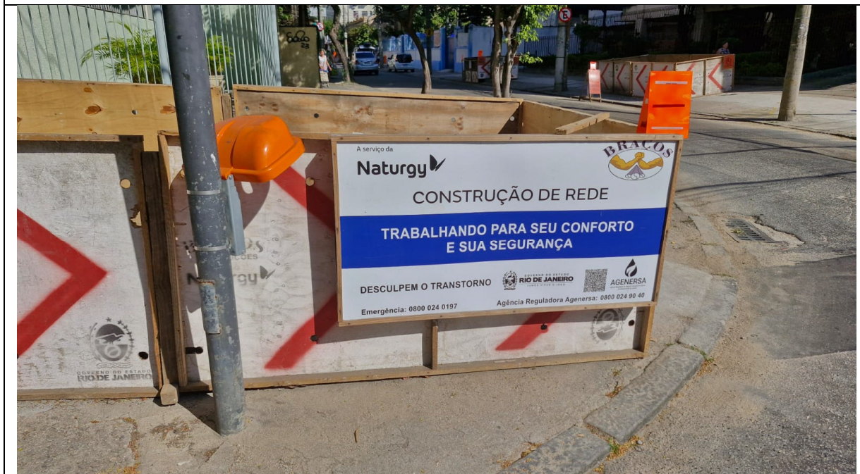
Foto 4: Aviso de obra, logo da Agenera e sinalização noturna.
