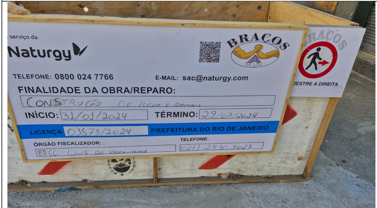
Foto 3: Identificação da obra, com sinalizações de desvio de pedestre.
