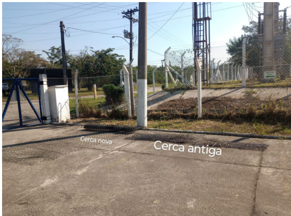
Foto 9: Substituição dos pontos da cerca que apresentavam buracos.
