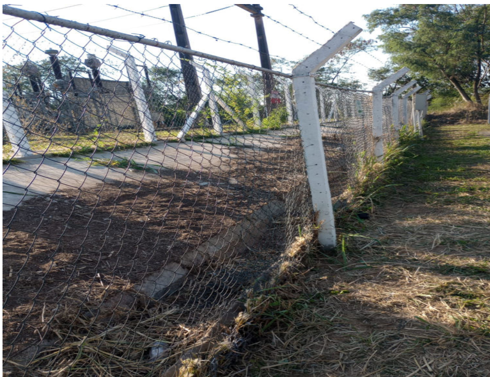
Foto 10: Substituição dos pontos da cerca que apresentavam buracos.
