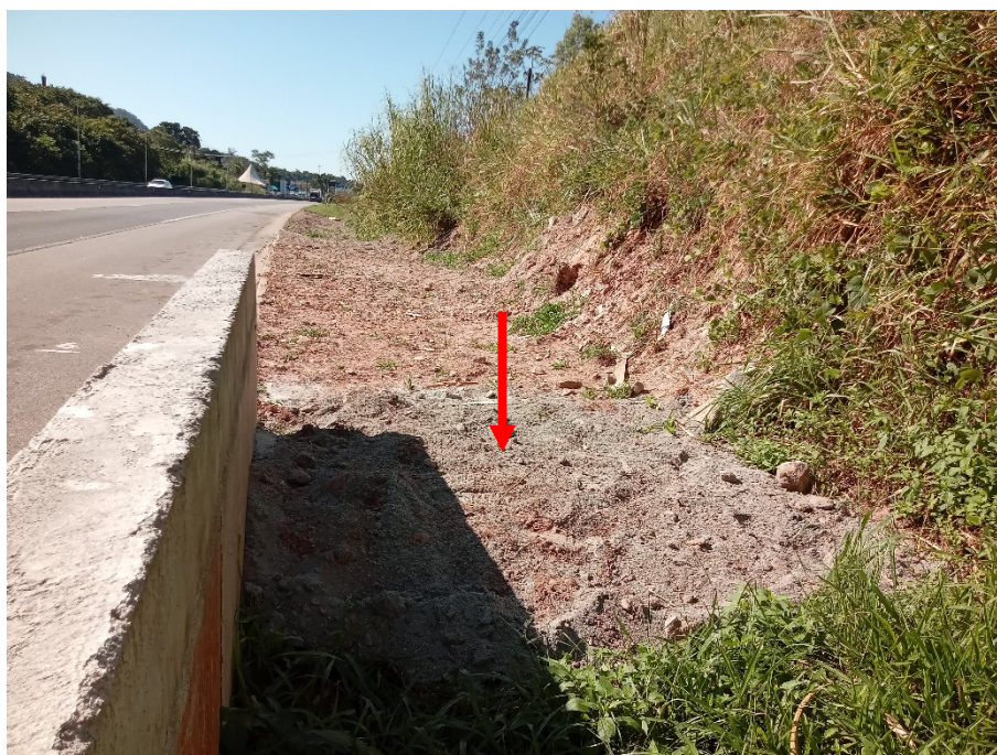
Foto 8: Ponto onde continua o assentamento de rede a montante do pedágio eletrônico.
