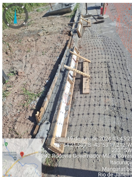
Foto 18: Adequação de meio fio.
