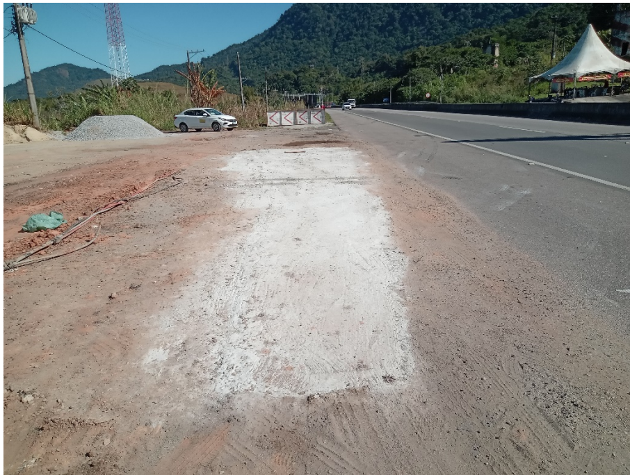
Foto 9: Recomposição em trecho onde houve abertura para passagem de tubulação.
