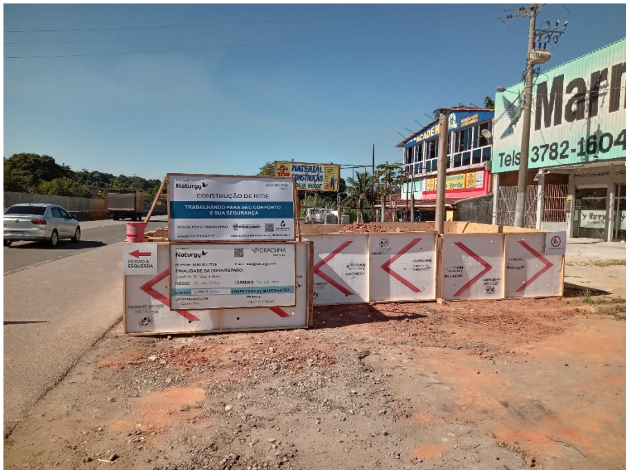
Foto 10: Identificação da obra em área isolada com tapume sinalizado.
