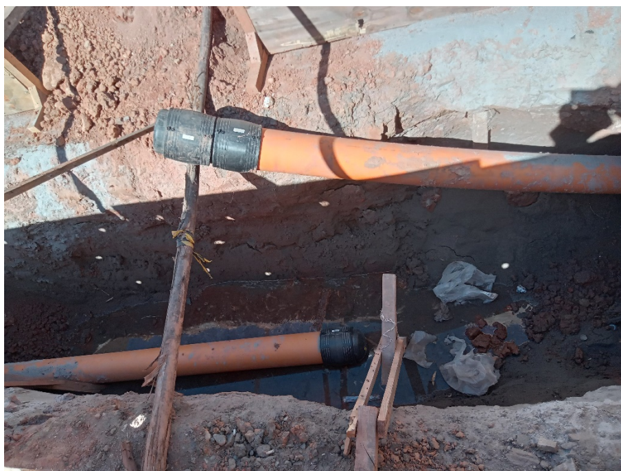
Foto 11: Pontas de rede a serem conectadas por eletrofusão.
