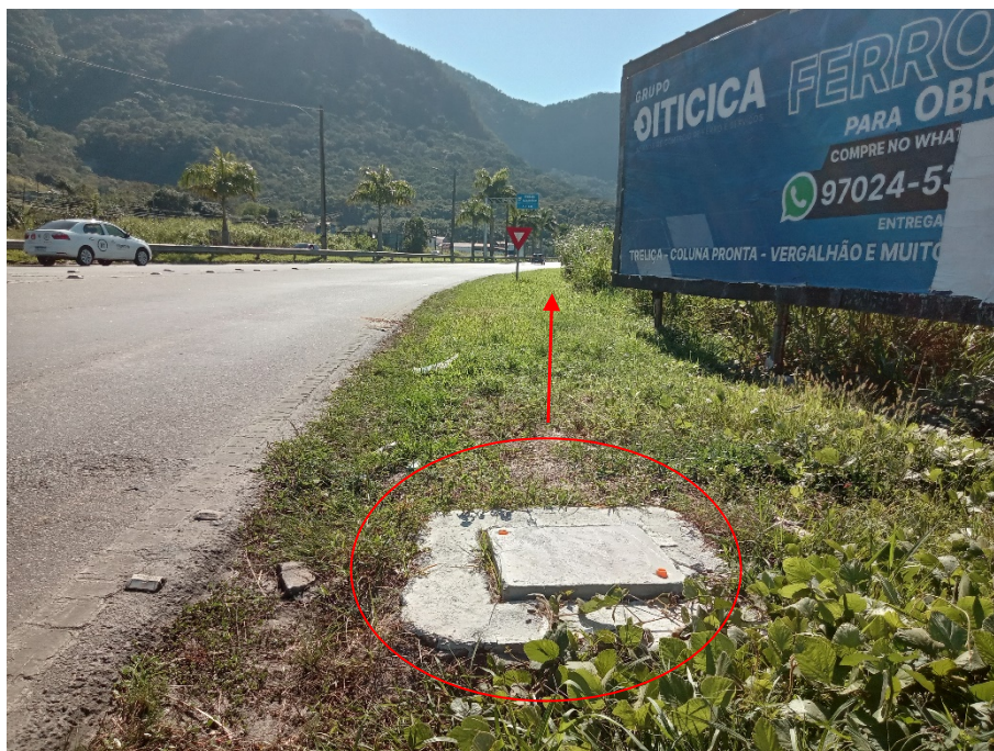
Foto 1: Caixa de válvula de rede (início do trecho 2).
