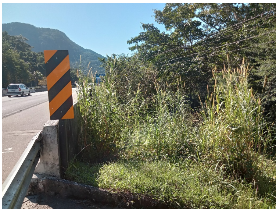
Foto 3: Ponte onde será realizada travessia aérea de tubulação de aço DN 8".
