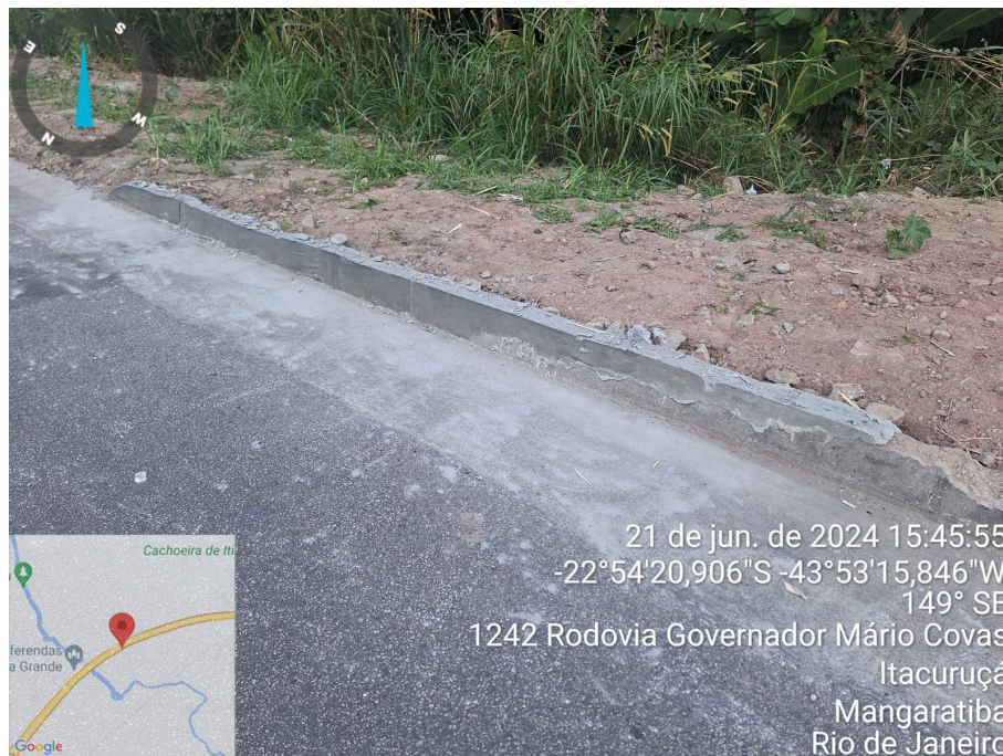
Foto 19: Adequação de meio fio.
