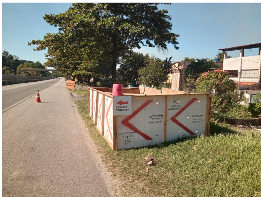
Foto 12: Isolamento de obra e sinalização.
