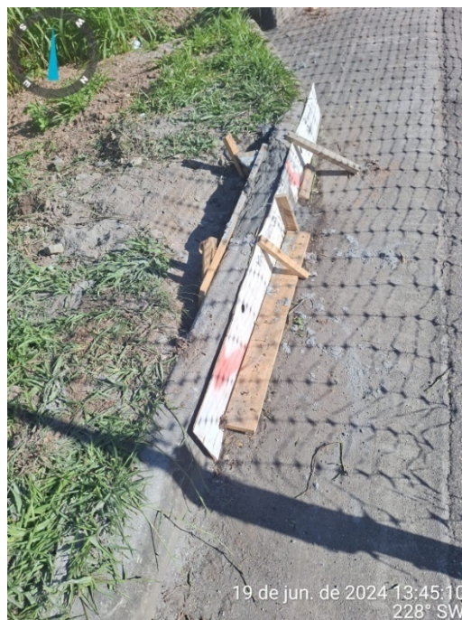
Foto 17: Reconstrução de meio fio.
