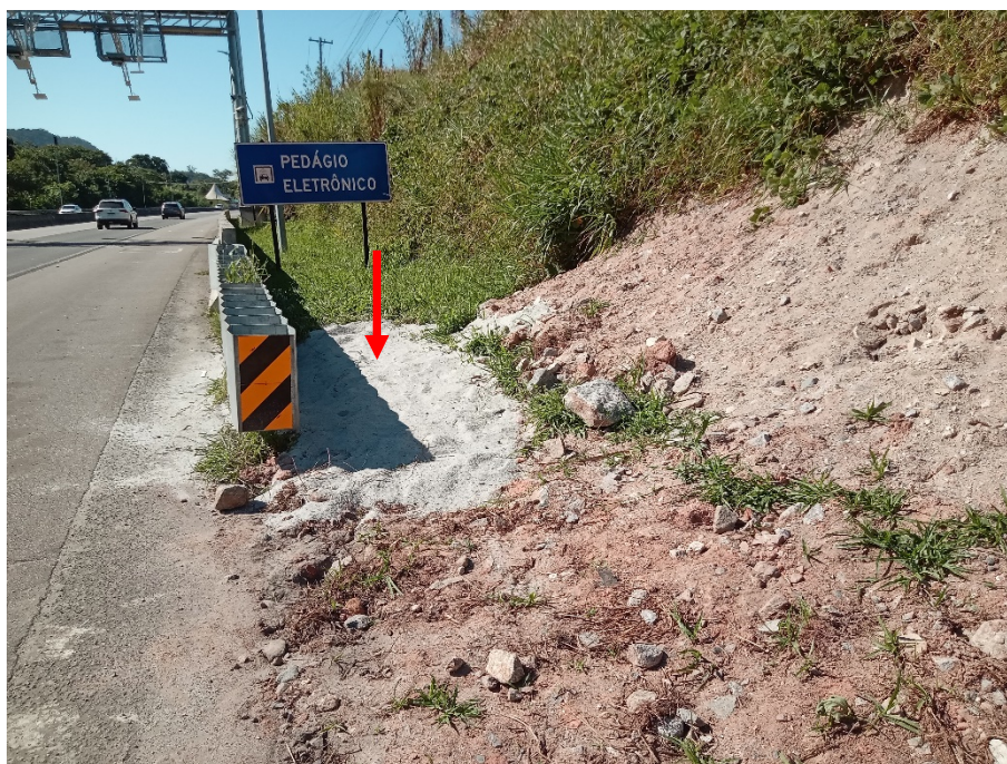
Foto 7: Ponta de rede parada devido interferência encontrada a montante do pedágio eletrônico.
