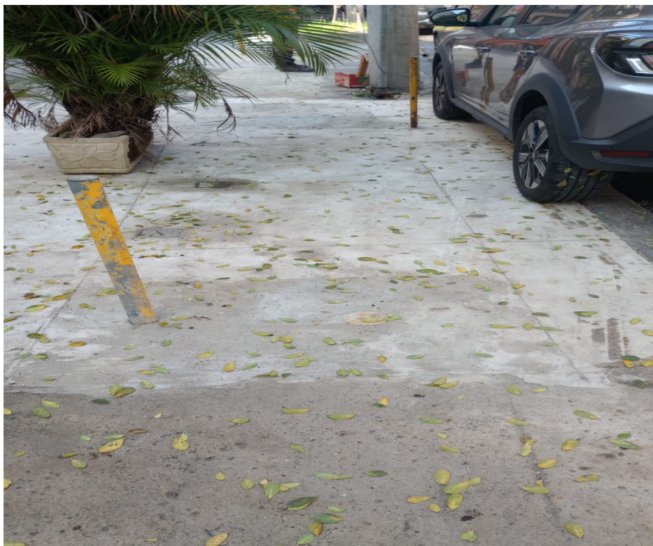
Foto 20: Conserto da recomposição rachando e marco plano se movendo, em frente ao imóvel nº 52.
