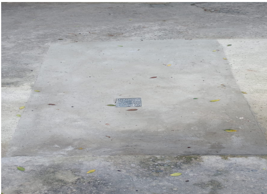
Foto 19: Conserto do afundamento na recomposição, em frente ao imóvel nº 46.
