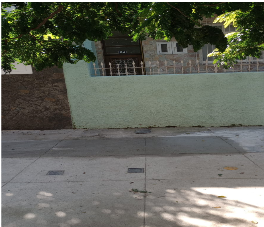
Foto 27: Conserto do piso original junto à obra danificada, em frente ao imóvel nº 64.
