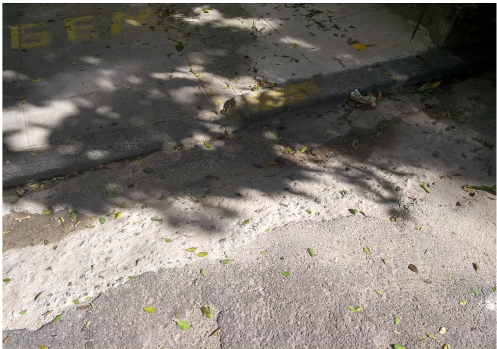
Foto 2: Recomposição provisória na via sem sinalização, em frente ao imóvel nº 105.
