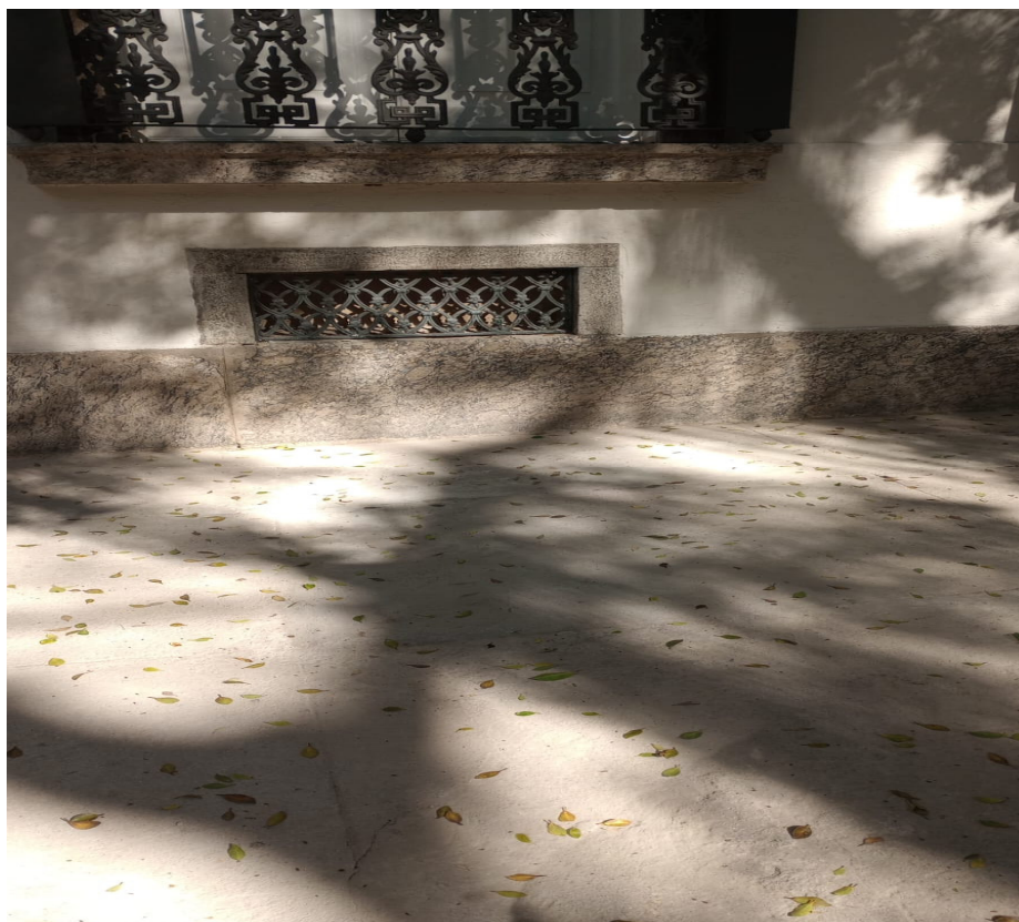
Foto 22: Conserto do buraco na recomposição, em frente ao imóvel nº 123.
