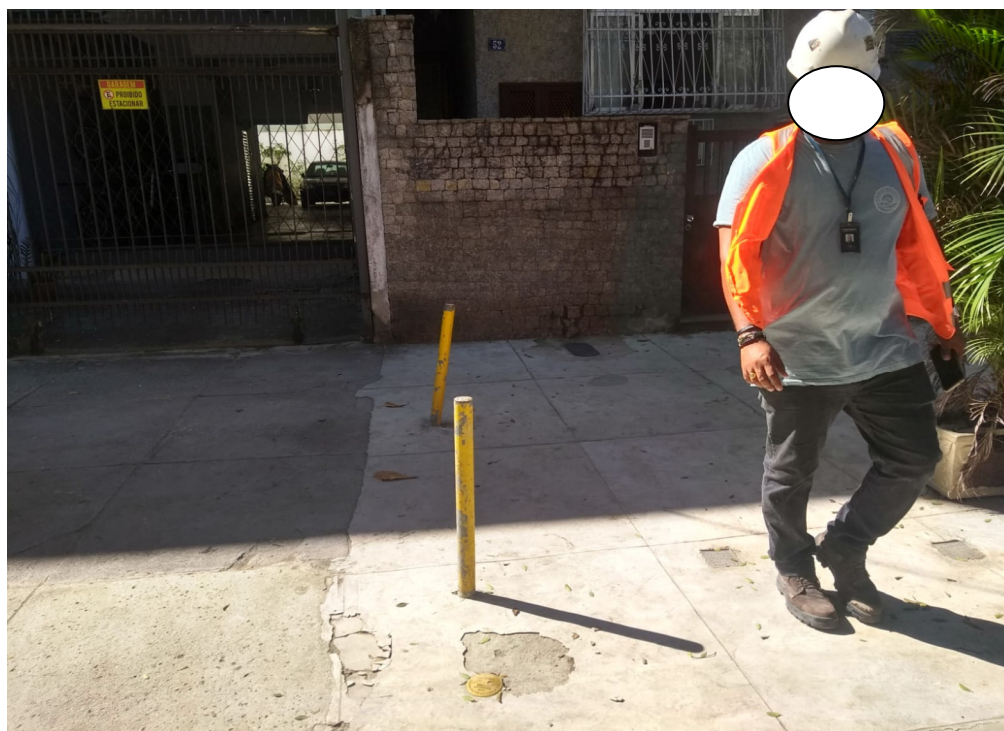
Foto 6: Recomposição rachando e marco plano se movendo, em frente ao imóvel nº 52.
