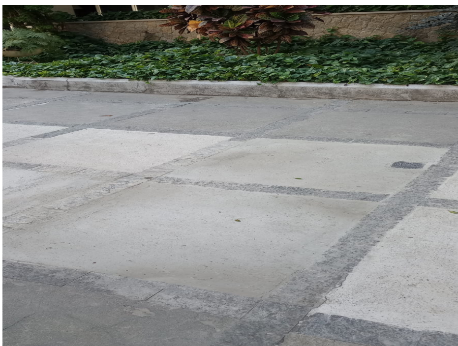
Foto 28: Conserto do afundamento na recomposição, em frente ao imóvel nº 108.
