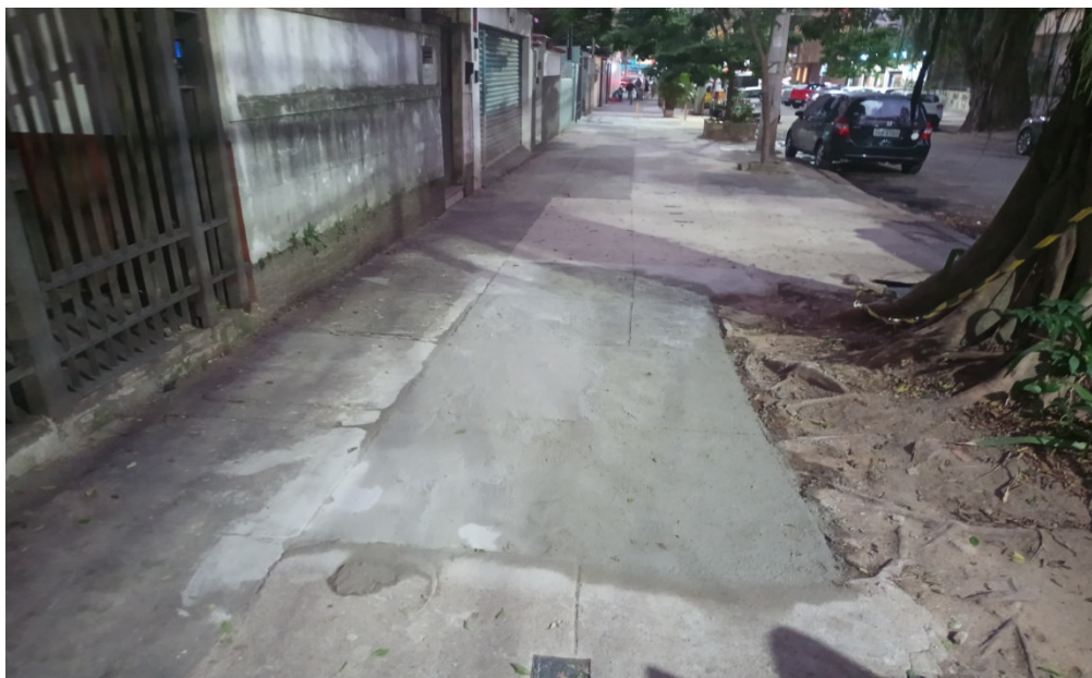
Foto 21: Conserto do buraco na imenda da recomposição com o piso original, em frente ao imóvel nº 90.
