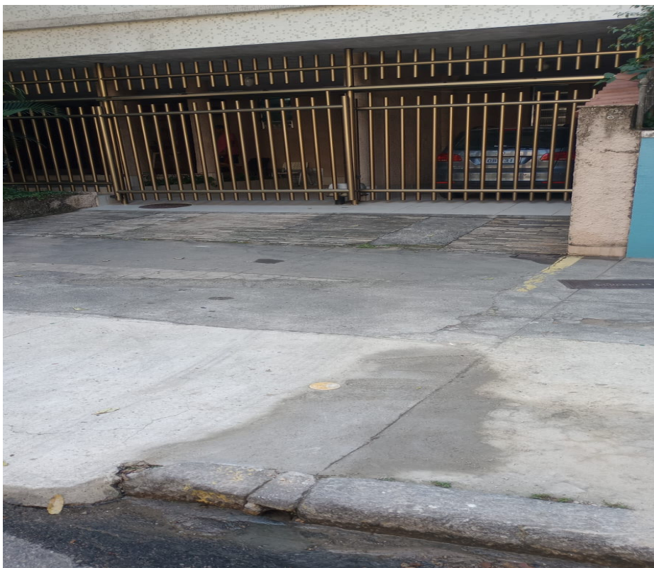
Foto 25: Conserto do buraco na imenda da recomposição com o piso original, em frente ao imóvel nº 226.
