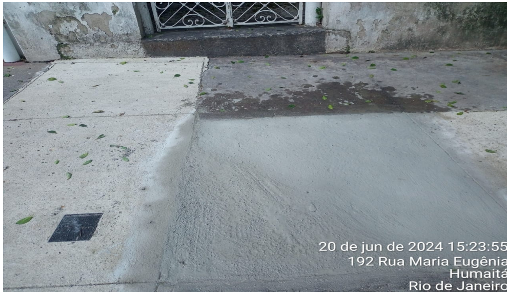
Foto 23: Conserto do buraco na imenda da recomposição com o piso original, em frente ao imóvel nº 172.
