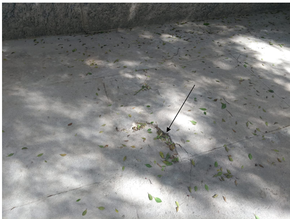
Foto 8: Buraco na recomposição, em frente ao imóvel nº 123.
