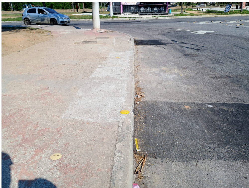
Foto 5: trecho de tubulação assentada.
