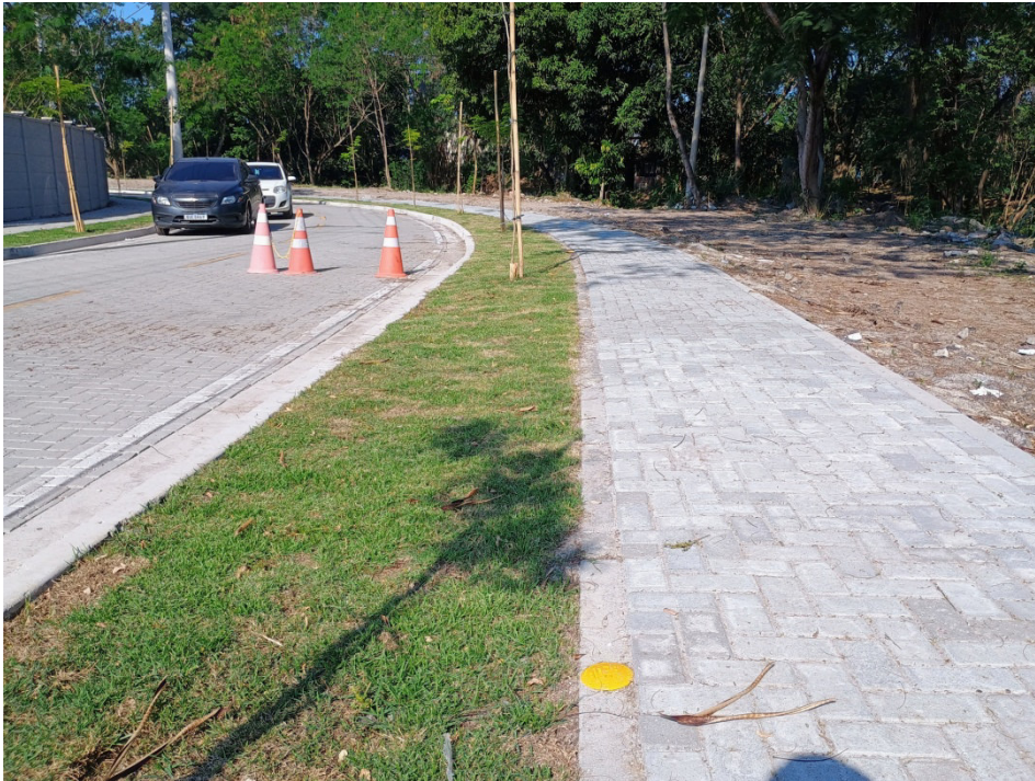
Foto 3: trecho de tubulação assentada.
