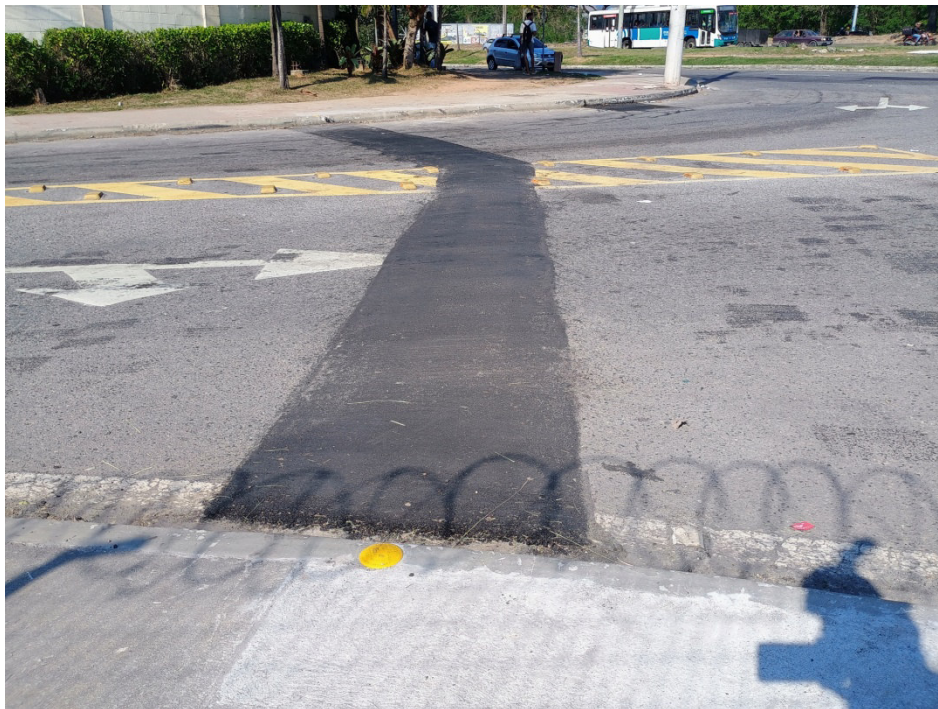
Foto 4: trecho de tubulação assentada.
