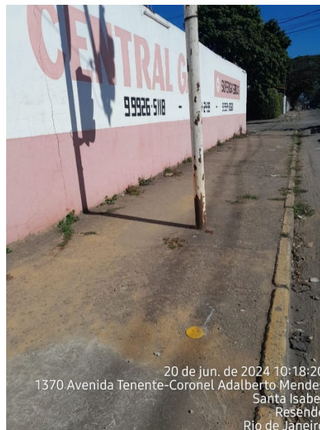
Foto 8: Instalação de marco plano (ponto de início da obra).
