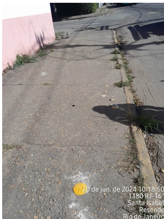
Foto 9: Instalação de marco plano.
