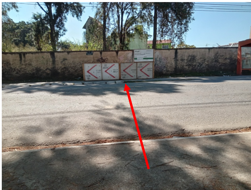
Foto 3: Trecho onde será realizada uma travessia de rede.
