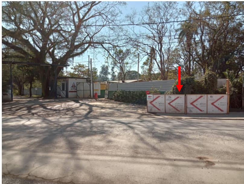
Foto 7: Final do trecho construído em PE Ø90 mm.
