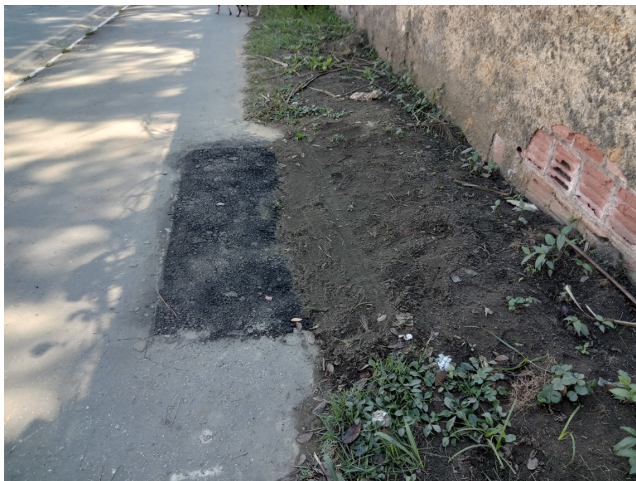
Foto 5: Recomposição em ponto onde houve abertura (lado par).
