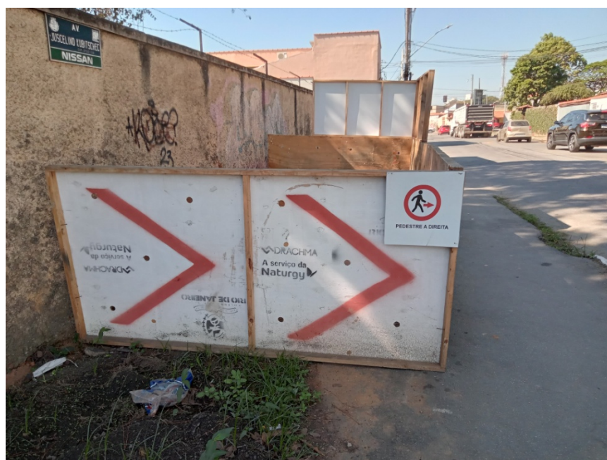
Foto 4: Isolamento de obra (ponta de rede parada no lado par).
