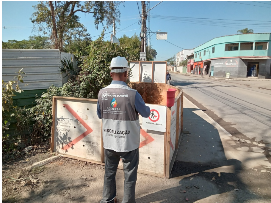
Foto 7: Trecho em inspeção (AGENERSA).
