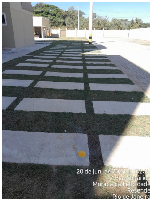
Foto 12: Instalação de marco plano.
