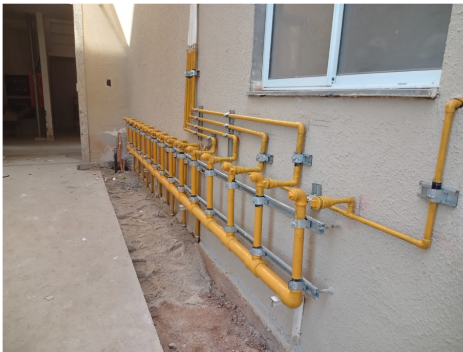
Foto 5: PI ainda em construção.
