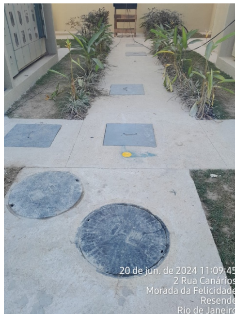
Foto 10: Instalação de marco plano.
