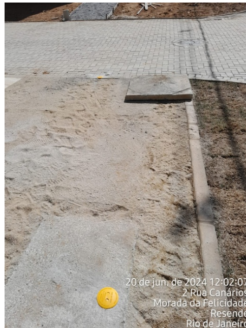
Foto 13: Instalação de marco plano.
