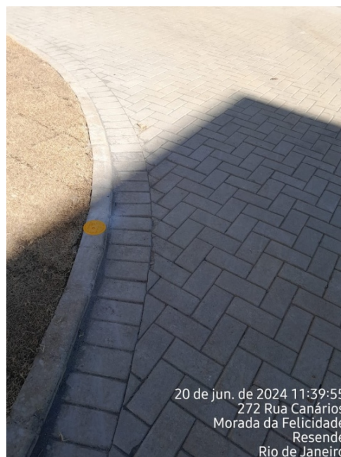
Foto 14: Instalação de marco plano.
