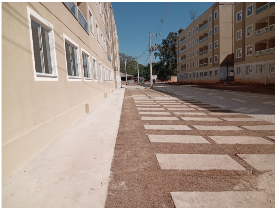
Foto 6: Local onde existe rede interna de gás instalada, porém sem marco plano.
