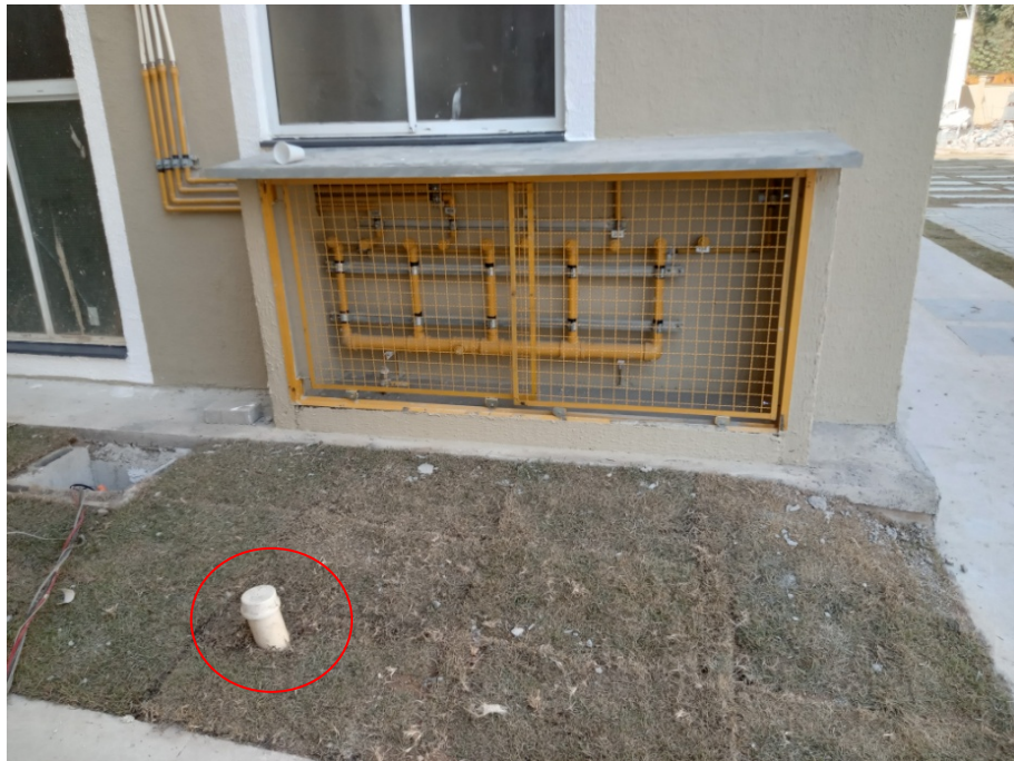
Foto 9: Caixa de válvula de ramal a ser instalada.
