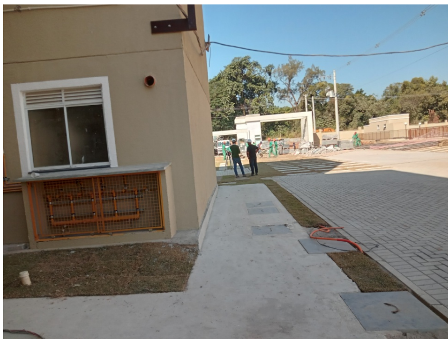
Foto 3: Abrigo de medidores e reguladores de pressão (4 bar / 220 mmca).
