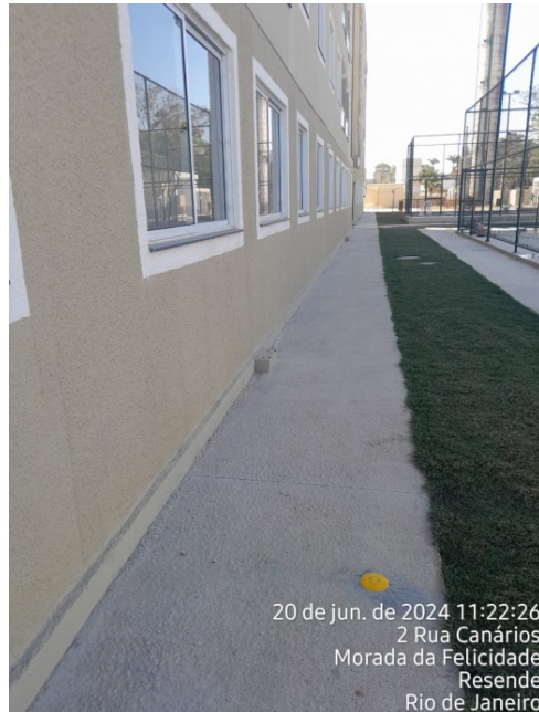
Foto 11: Instalação de marco plano.
