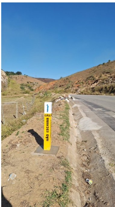
Foto 17: Marco vertical instalado indicando presença de rede de gás.
