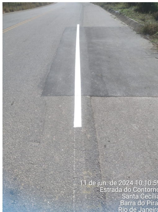
Foto 15: Pintura da linha de bordo da via.
