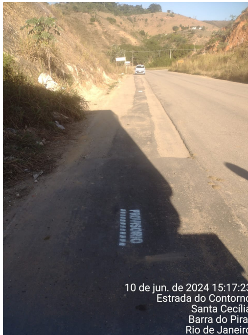
Foto13: Marcação de recomposição provisória.
