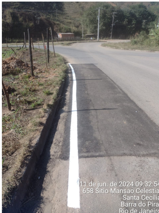
Foto 14: Adequação de pintura da linha de bordo da via.
