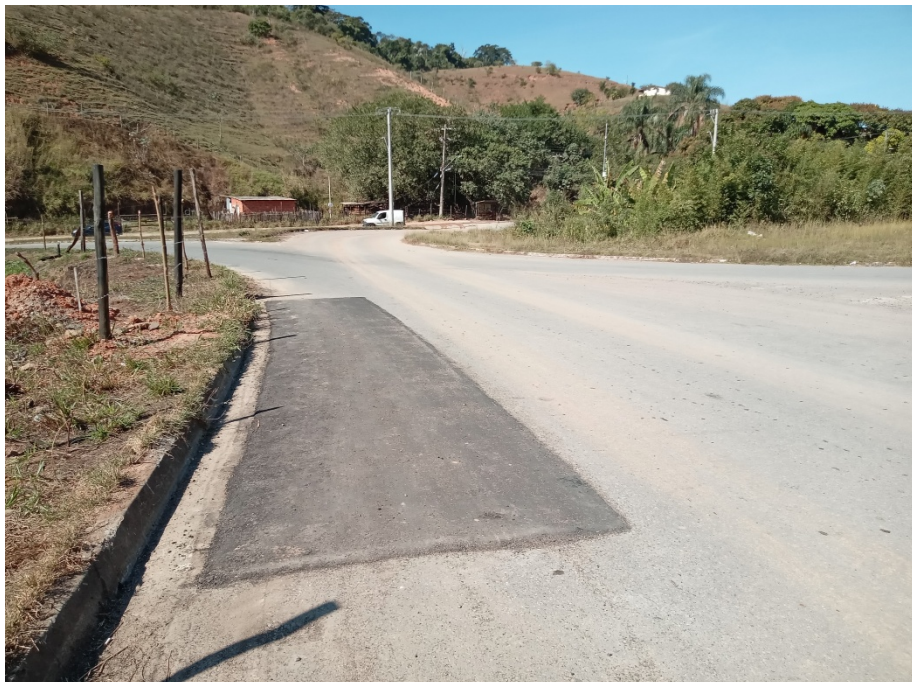
Foto 2: Ausência de pintura da linha de bordo em local de recomposição.
