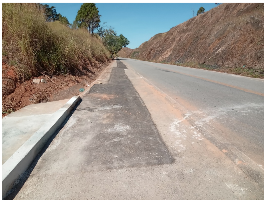
Foto 7: Recomposição da via, passeio e meio fio.
