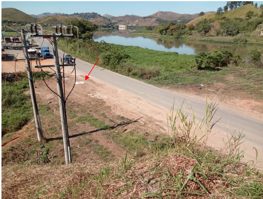
Foto 11: Caixa de válvula de rede a jusante do elevado, próximo ao ponto de interligação à rede da fase I.
