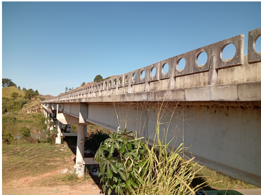
Foto 10: Elevado onde será construída a rede de aço de 8 polegas.
