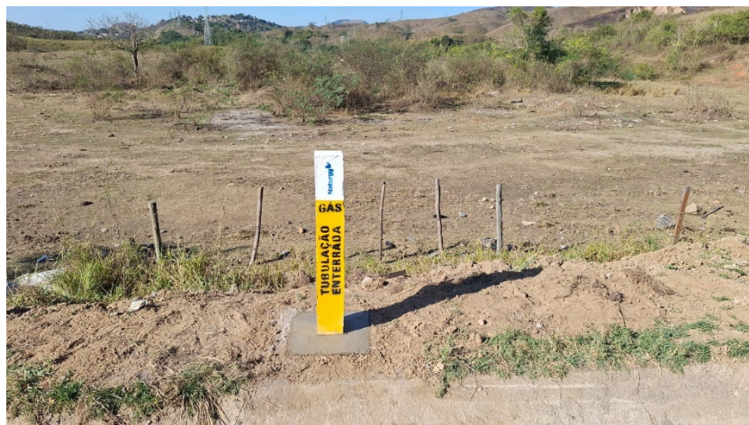
Foto 16: Instalação de marco vertical.
