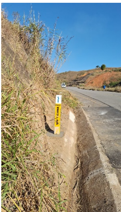
Foto 18: Marco vertical instalado indicando presença de rede de gás.
