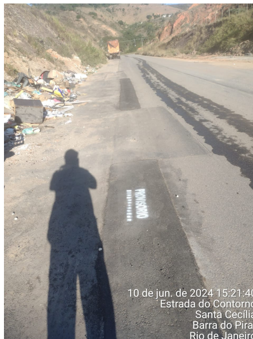
Foto 12: Recomposição provisória após identificação.
