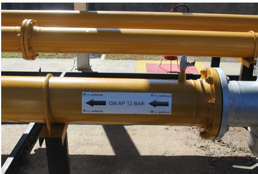
Foto 5: Indicação do sentido de fluxo e pressão do gás.
