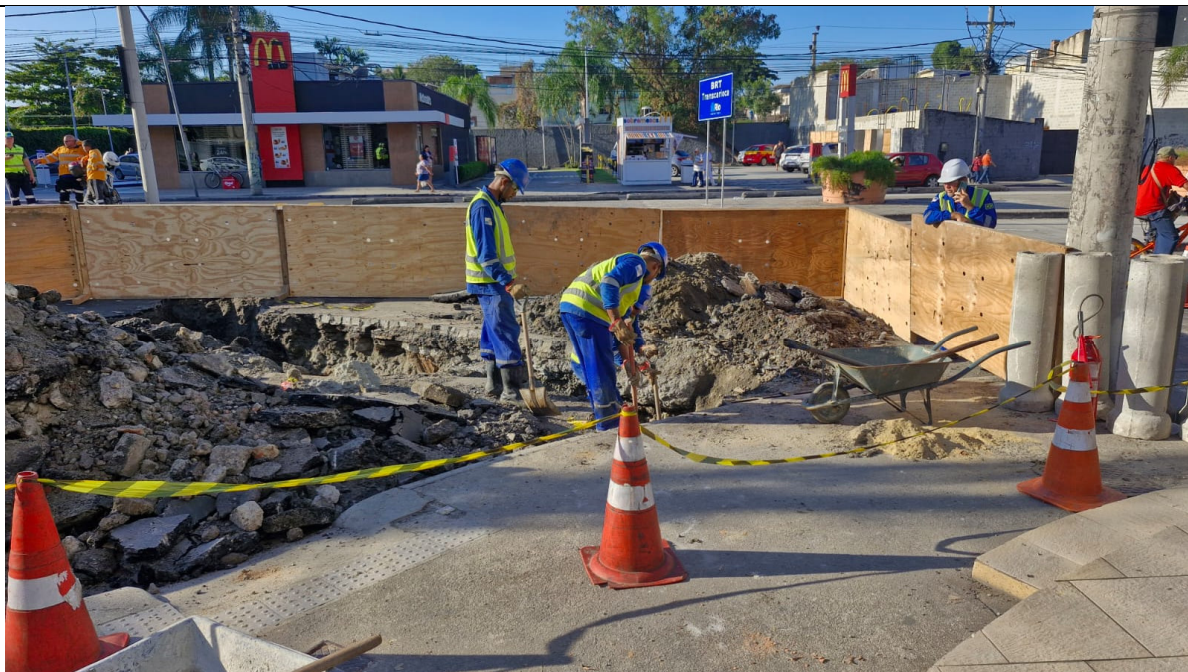
Foto 3: Equipe de reparos trabalhando na obra. Extintor em condições de uso no canto direito.
