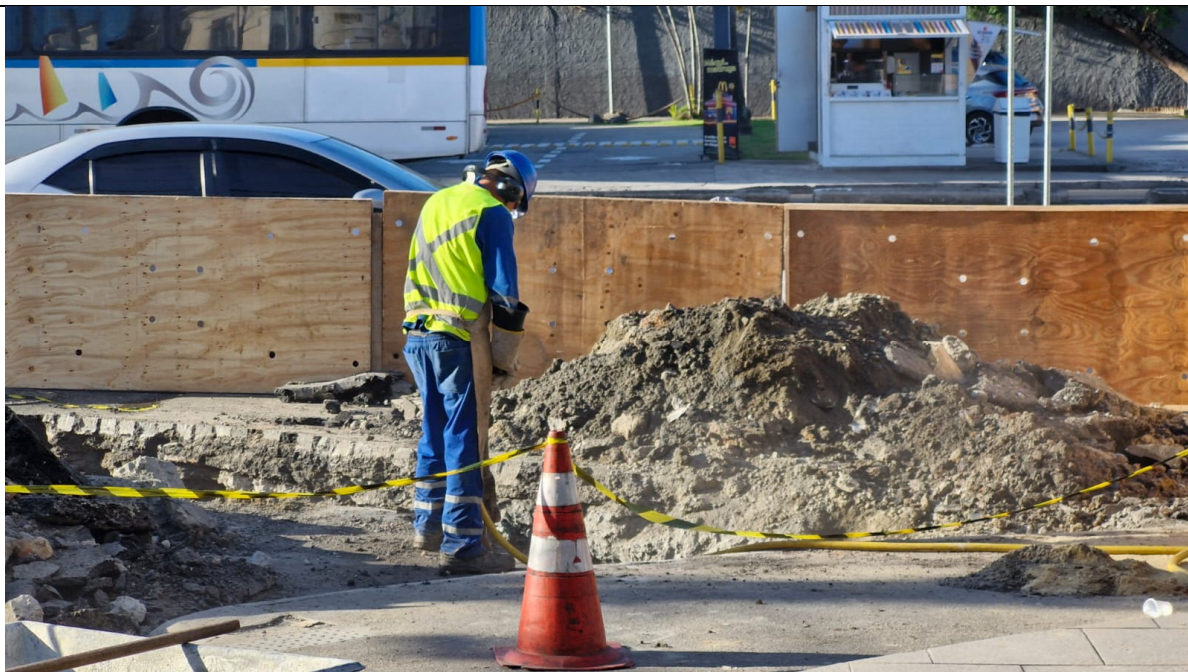
Foto 5: Colaborador utilizando britadeira para facilitar acesso aos dutos para reparo definitivo. EPI, incluindo proteção auricular, em ordem.
