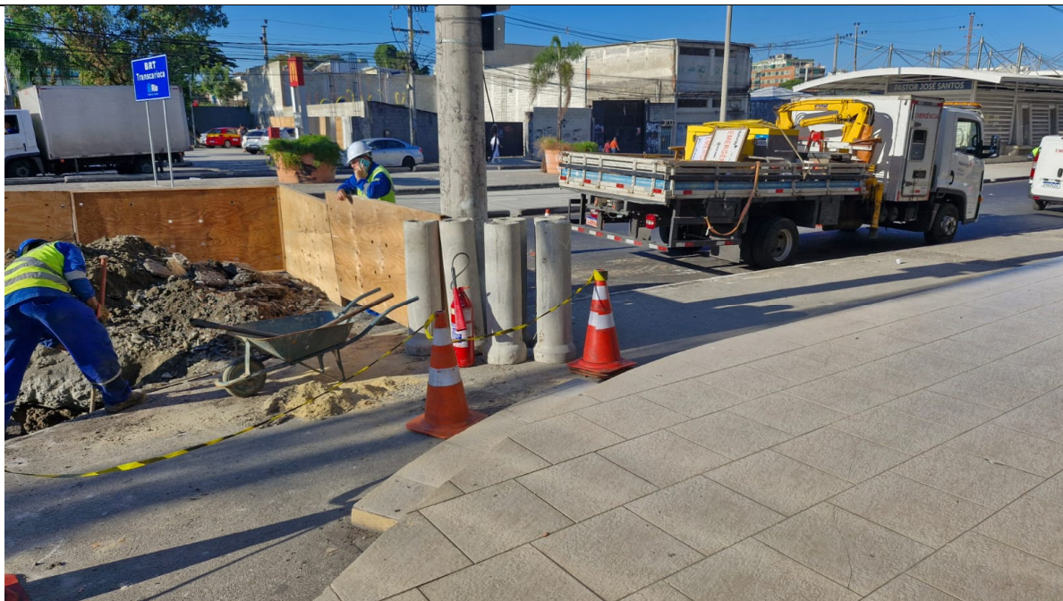
Foto 1: Área da intervenção para reparo de emergência, com isolamento.
