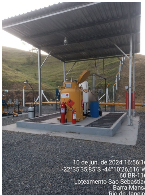
Foto 14: Adequação de extintor de incêndio sobre rodas.
