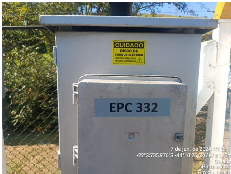
Foto 13: Adequação de sinalização de segurança em painel elétrico.
