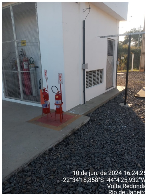
Foto 18: Adequação de extintor.
