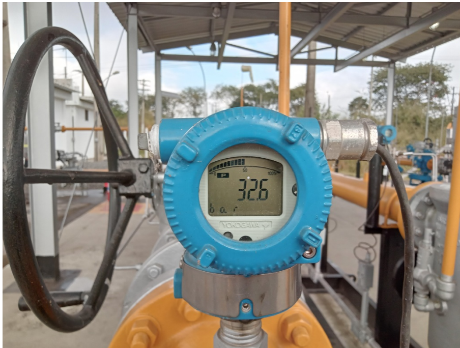
Foto 7: Indicação da pressão na linha de entrada da ETC Cidade do Aço.
