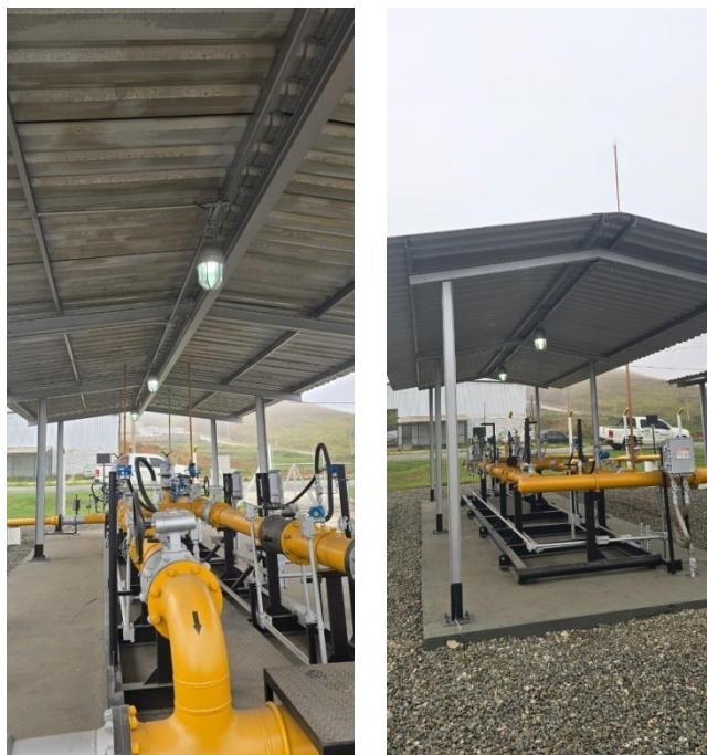
Foto 14: Adequação do sistema de iluminação.
