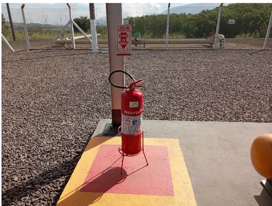
Foto 11: Extintor de incêndio PQS.
