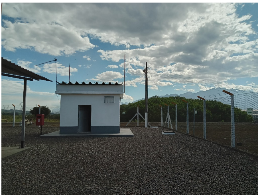
Foto 12: Sala de comando.
